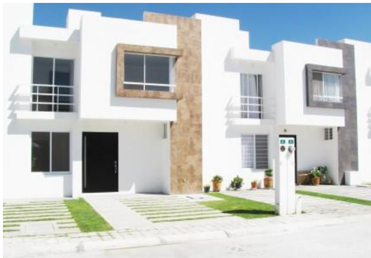
Foto 3.32. Tipo de vivienda fraccionamiento mediterráneo.
