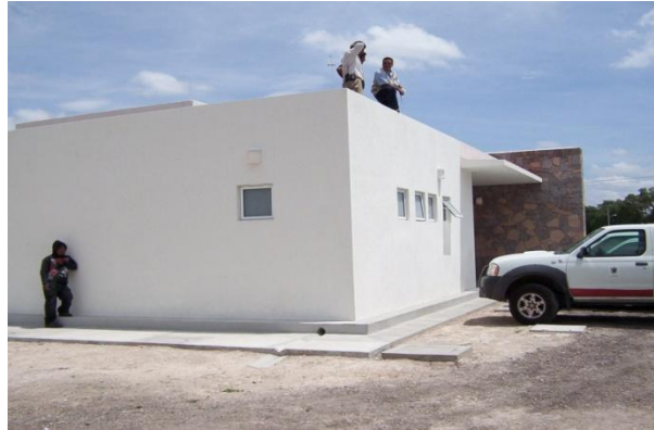
Foto 3.42. Construcción del Centro de Salud.
