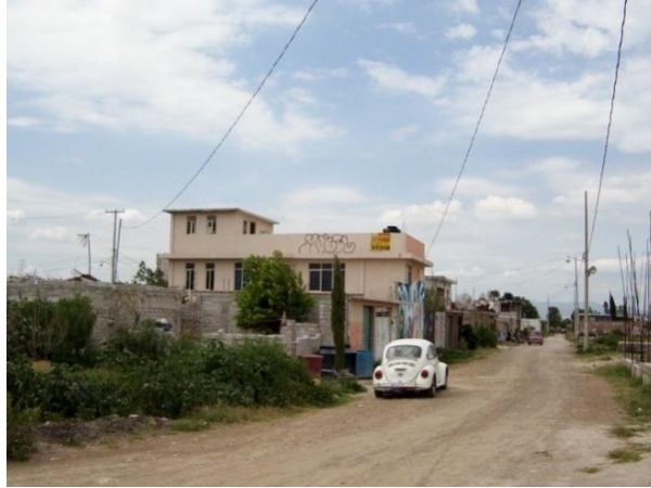
Foto 3.39. Banquetas y alumbrado público.
