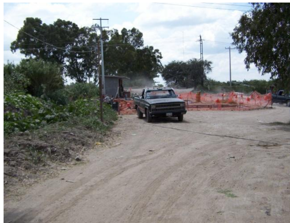
Foto 3.10. Depósito de aguas residuales.
