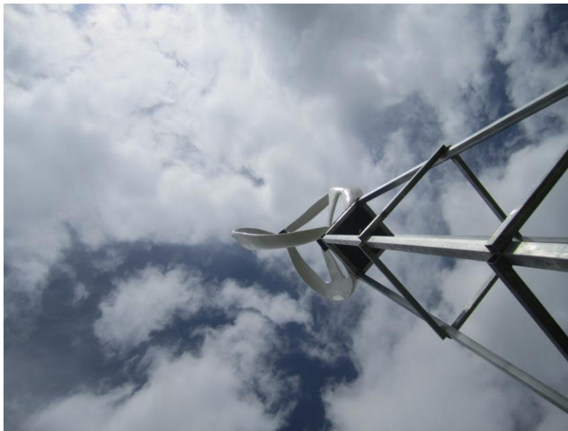
Figura 51. Instalación completa del aerogenerador, vista 2.
