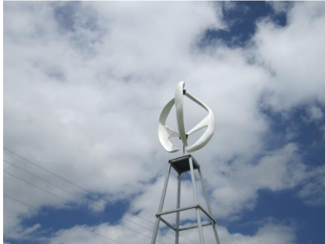
Figura 52. Instalación completa del aerogenerador, vista 3.
