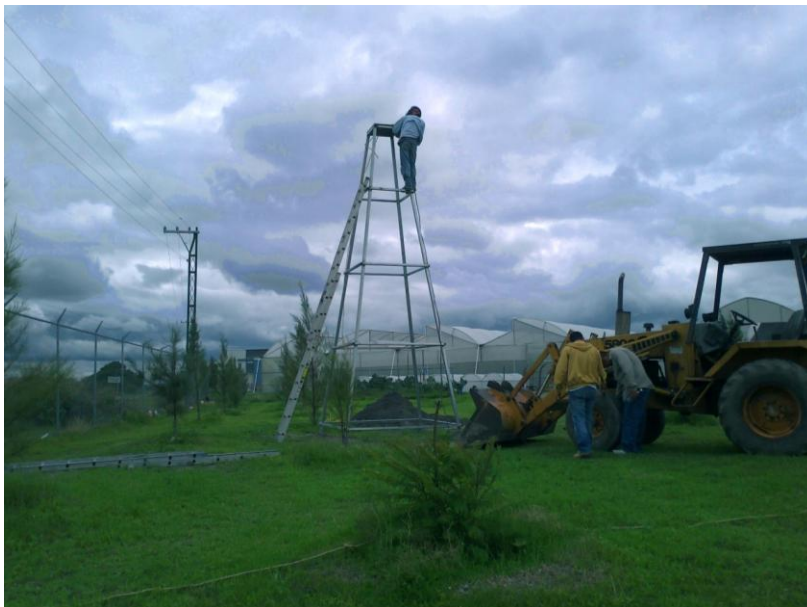
Figura 49. Instalación de la estructura base para el aerogenerador.
