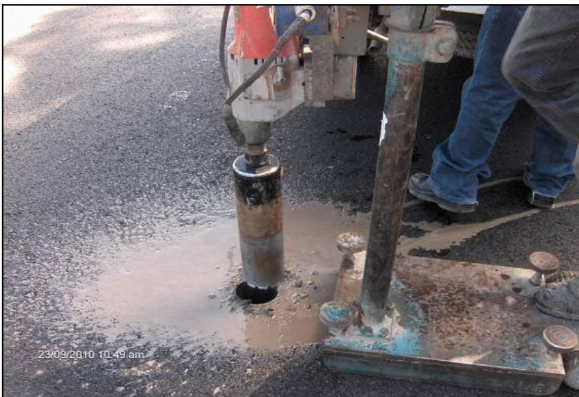
Figura 3. 1 Extracción de núcleos de carpeta asfáltica
