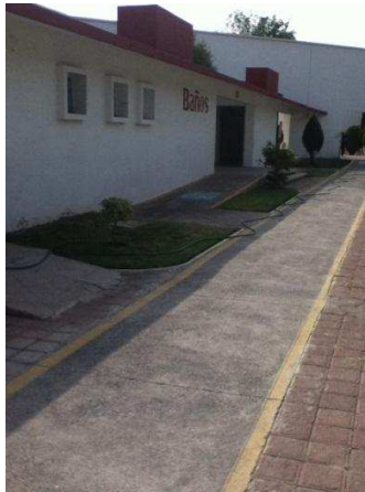
1.11 Rampa de acceso a baños de las canchas de basquetbol y pista de atletismo.
