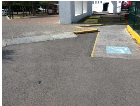
1.8 Rampa de descenso dentro de las instalaciones del Parque Querétaro 2000
