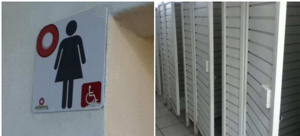
Figura 3.5 Izquierda: Señalética localizada en el polideportivo para acceder a los baños. Derecha: Baños del polideportivo con puertas sin acceso para personas con discapacidad.
