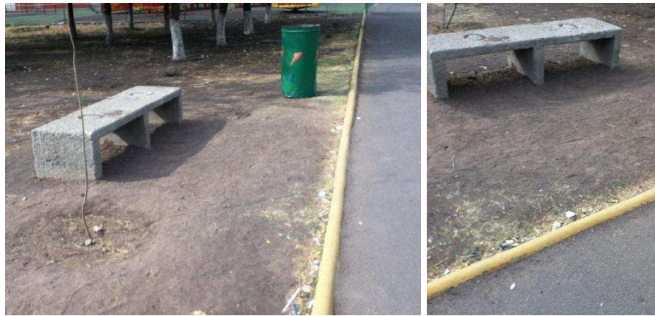
1.13 Bancas de concreto localizadas a un costado del camino principal
