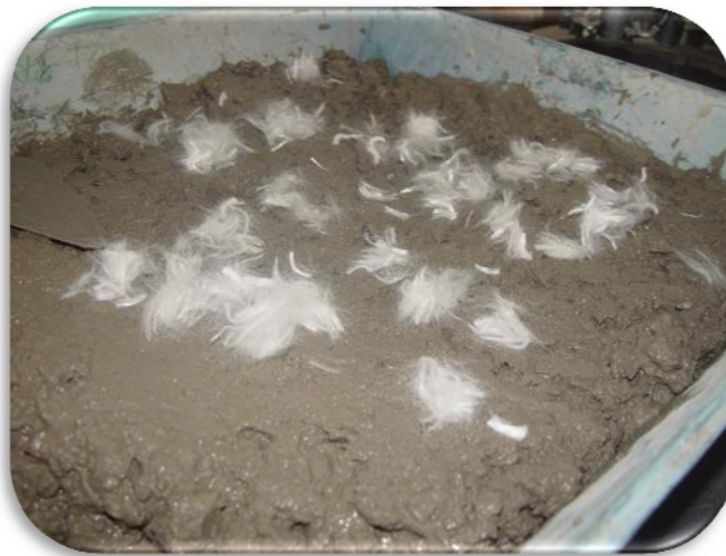
Figura 3.5 Adición de sikafiber
