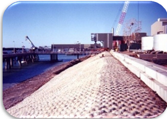
Figura 1.3 a) Configuración del sistema flexblock b) Colocación del flexblock en el terreno ( www.revetmentsystems.com/products.html , consultado en 2009)
