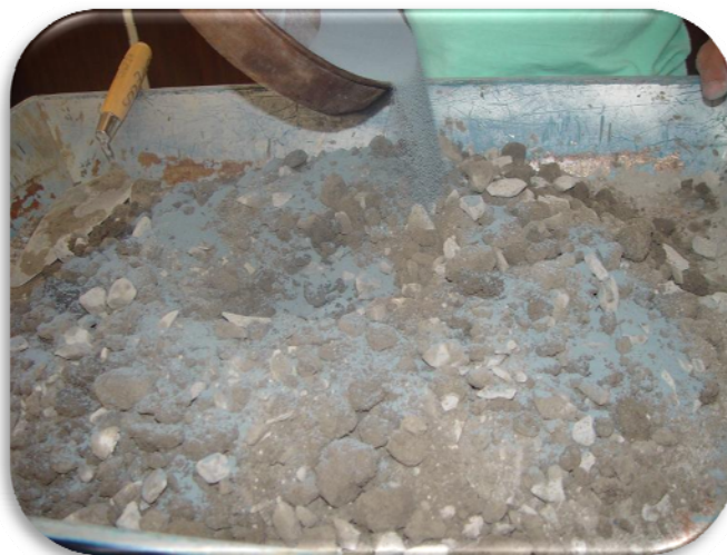
Figura 3.4 Adición de sikacrete 950-DP
