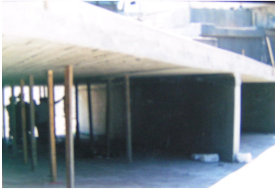
Figura 5.28. Inspección al puente.
