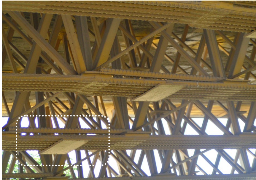
Figura 5.53. Refuerzo a Flexión.
