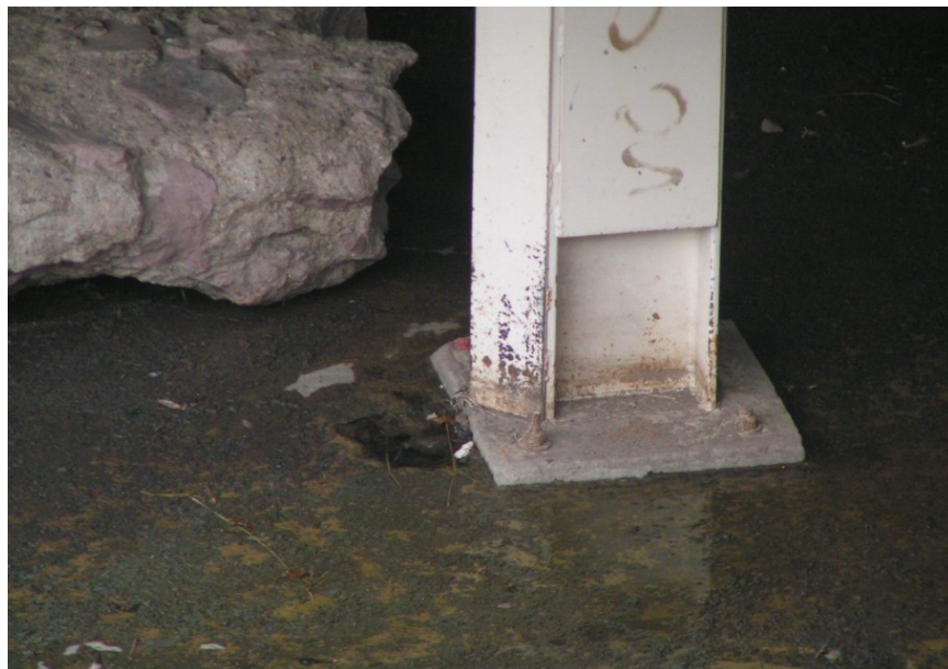
Figura 5.37. Detalle de apoyo principal y colocación de ángulo de desvío de agua.
