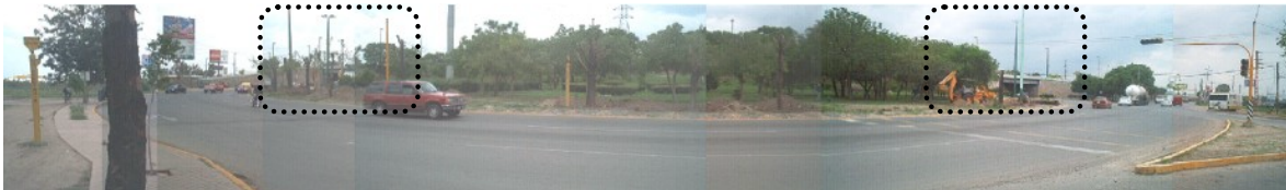
Figura 5.41.- Vista Panorámica en glorieta - Derecha: Puente 1; Izquierda: Puente 2
