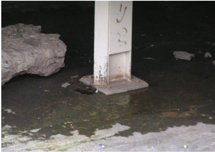
Figura 5.34 .Anclaje, Placa base y Columna de acero en posición.
