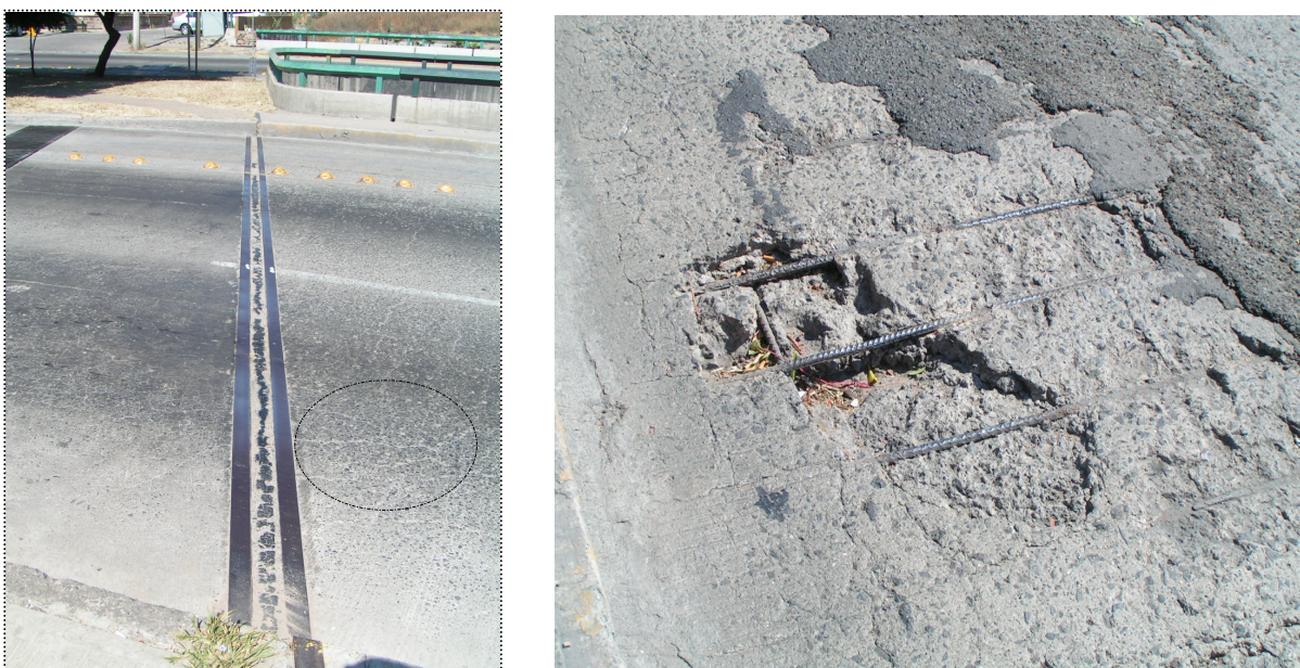
Figura 5.6 Patrón de Falla 5. Astillamiento.
