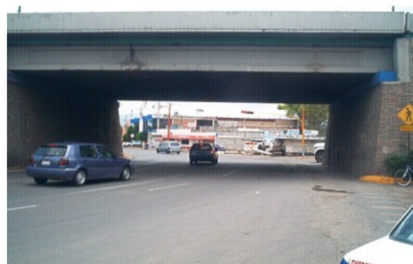
Figura 5.42 b.- Puente 2: Vista General
