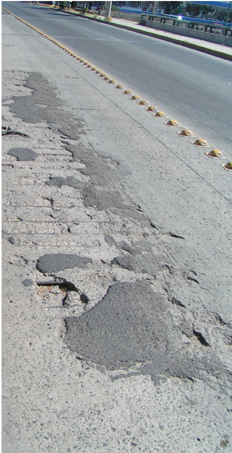
Figura 5.7 Patrón de Falla 5. Astillamiento.
