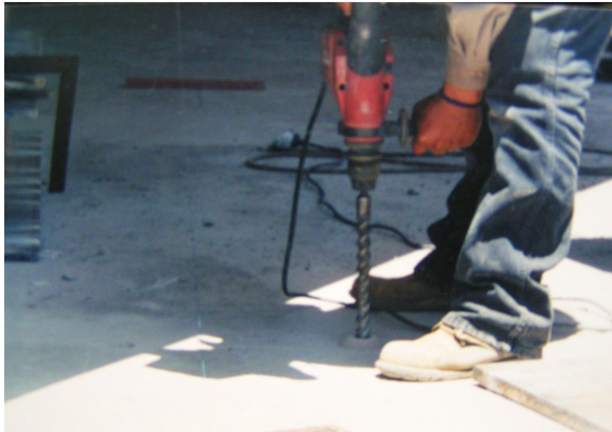
Figura 5.33. Procedimiento de perforación para anclaje.
