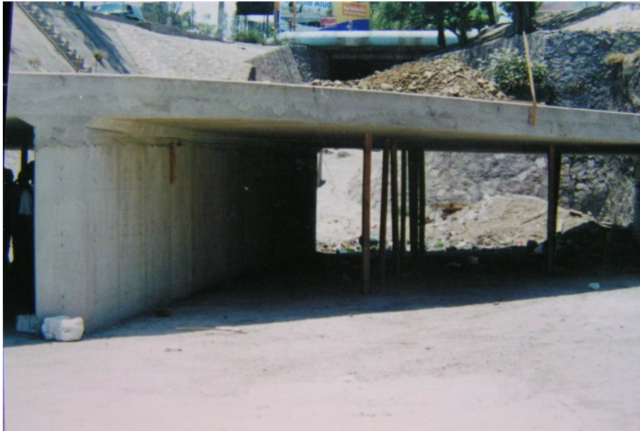
Figura 5.30. Inspección del puente.
