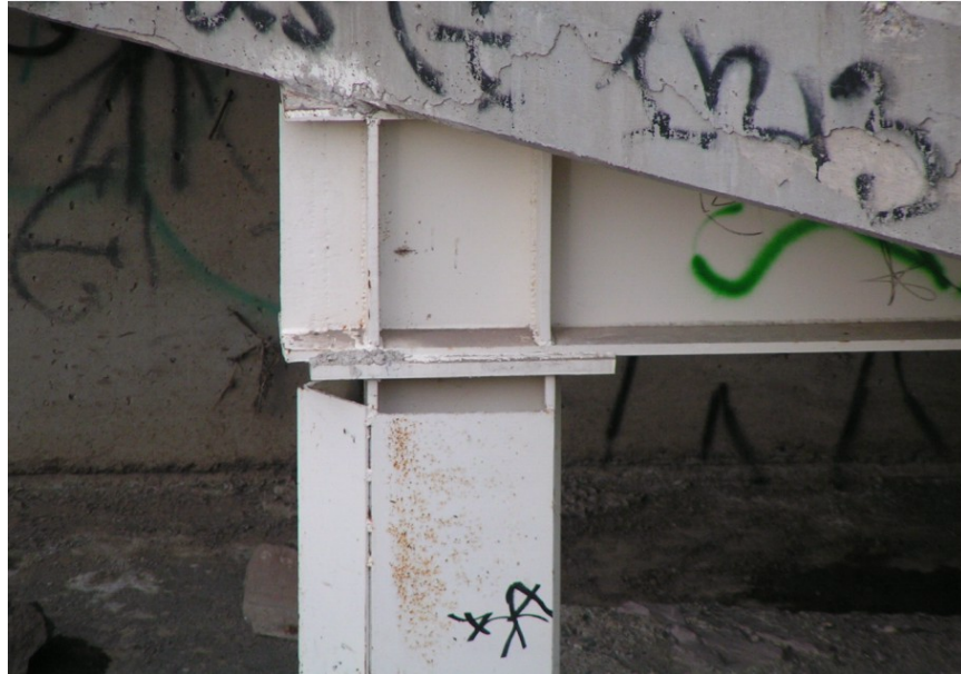
Figura 5.36. Detalle de conexión de trabe-columna.
