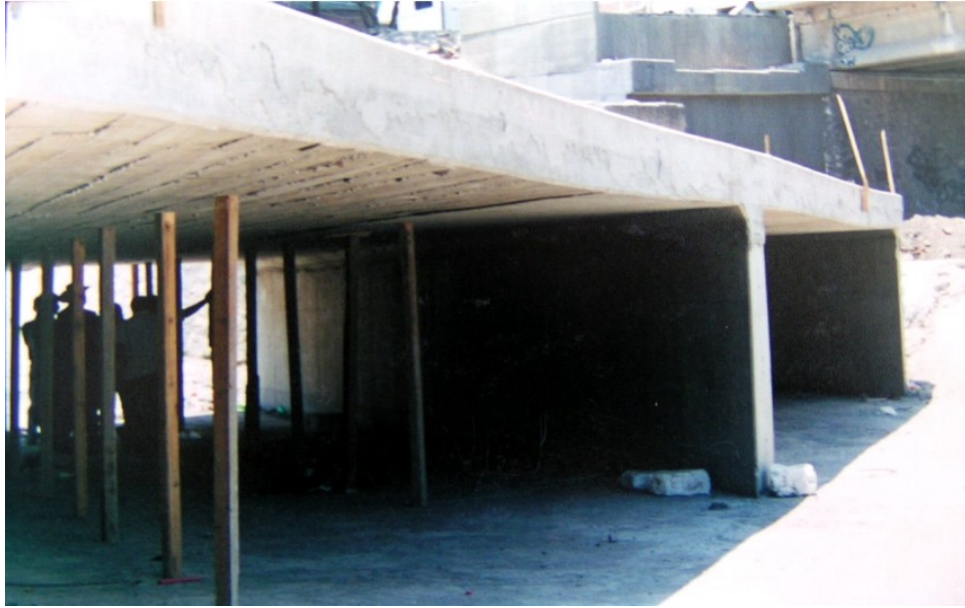
Figura 5.32. Inspección del puente.
