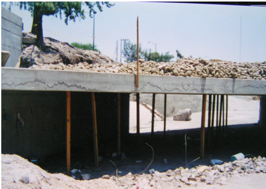
Figura 5.31. Inspección del puente.
