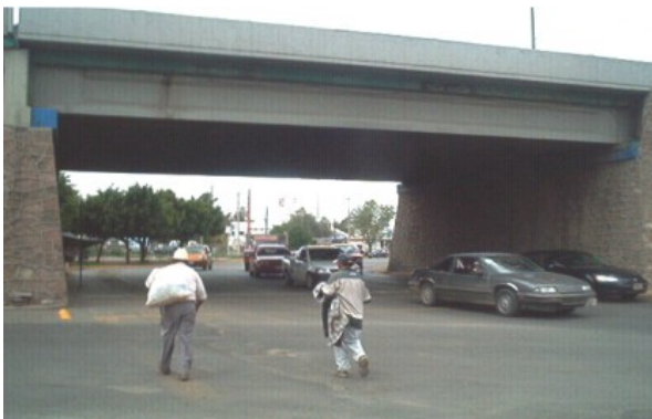
Figura 5.42a.- Puente 1: Vista General
