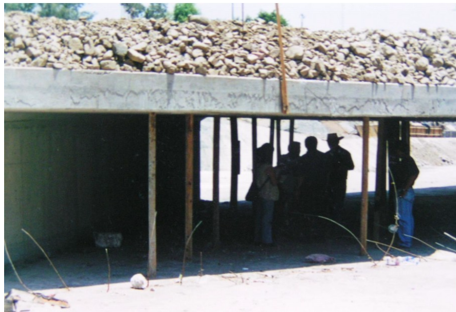
Figura5.29. Inspección al puente.
