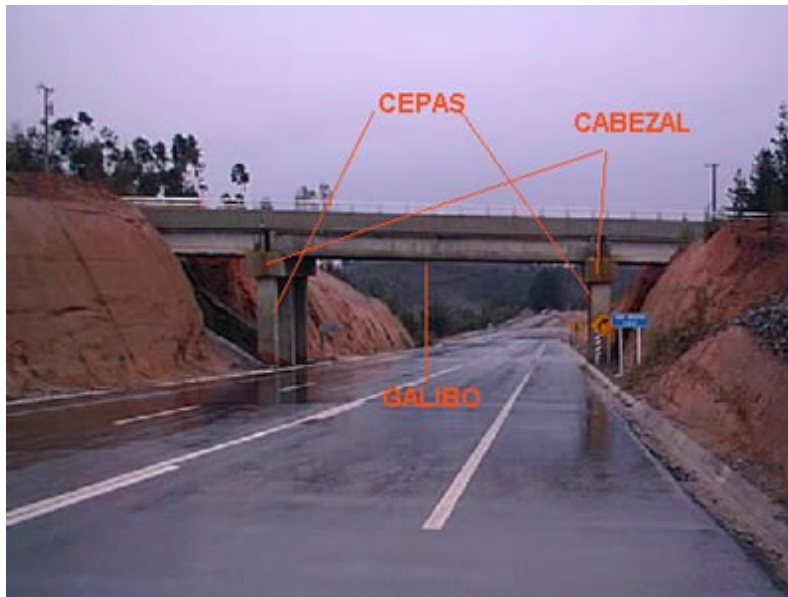
Figura 1.6 Descripción de elementos de un puente.
