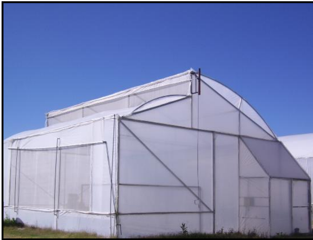
Figura 2. Invernadero tipo capilla a doble capa con cubierta de polietileno.
