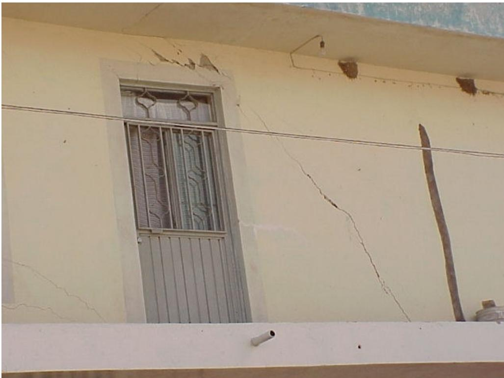
**Fig. 3.4** Falla típica de tensiona diagonal
