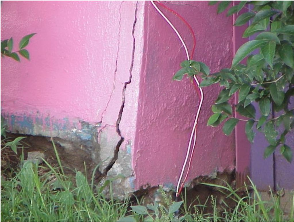
**Fig. 3.5 Falla típica de contracción en zapata aislada**
