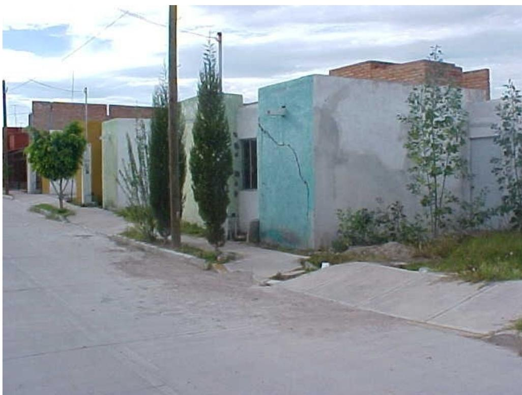
**Fig. 3.2 Efectos de movimientos diferenciales de la cimentación.**
