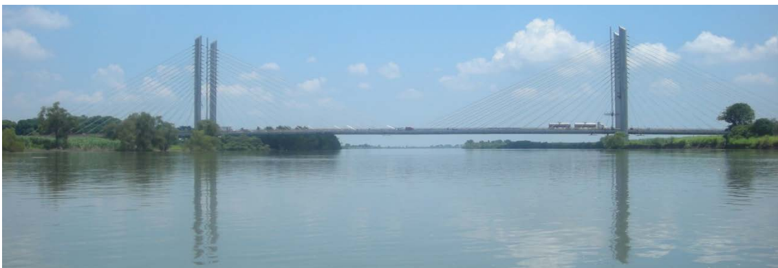
FIGURA 31 VISTA GENERAL DEL PUENTE RÍO PAPALOAPAN
