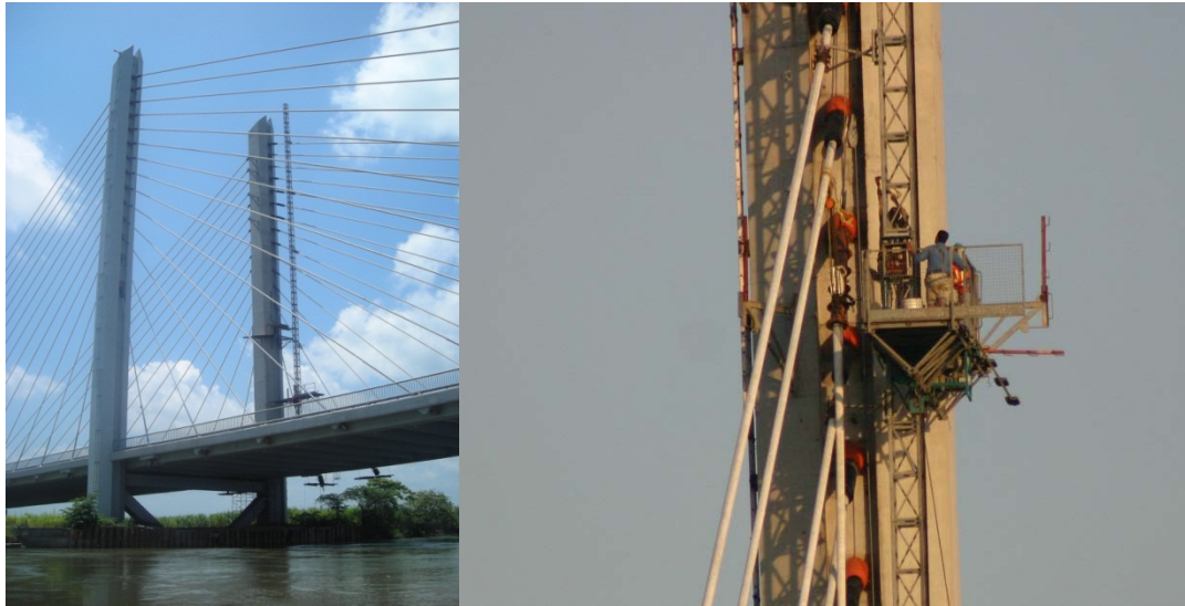
FIGURA 12 TRABAJOS DE REHABILITACIÓN EN EL PUENTE RÍO PAPALOAPAN
