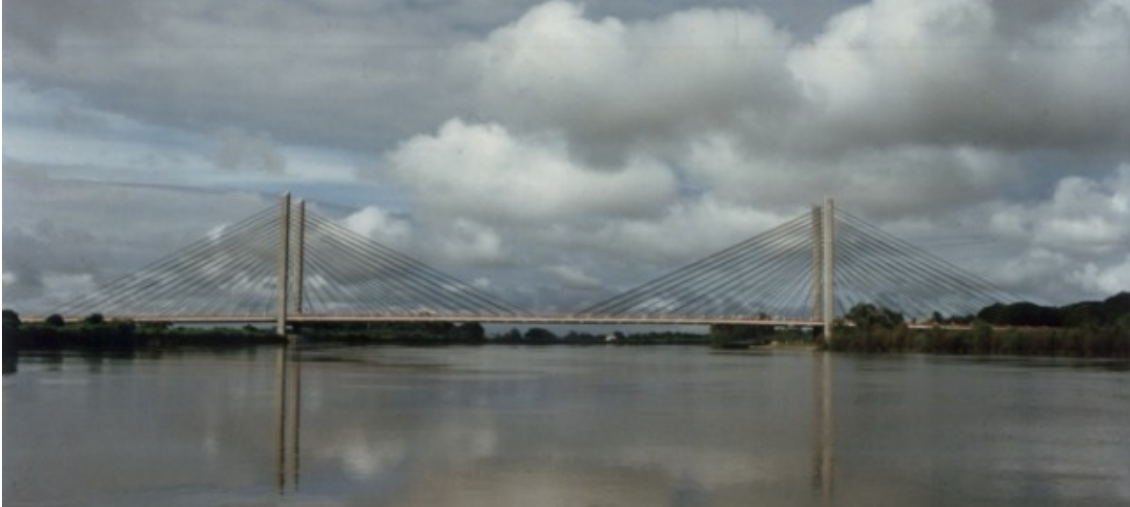
FIGURA 1 FOTOGRAFÍA DEL PUENTE PAPALOAPAN
