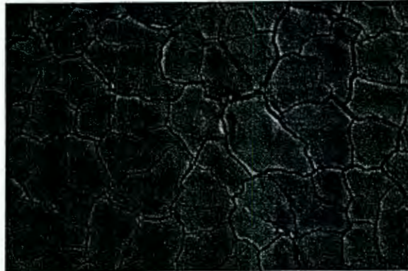
Figura 2.3 Suelo Expansivo que demuestra las grietas
