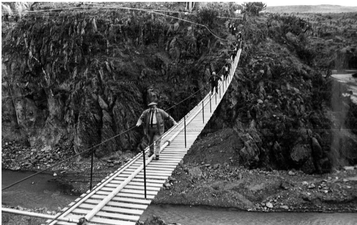
Fotografía 4. Puente colgante provisional colocado en la boquilla del cañon de La Begoña sobre el río Laja y visita de autoridades durante la construcción de la presa en diciembre de 1965.
