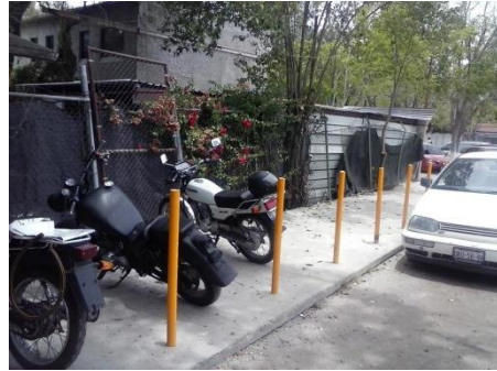
Figura 49. Pasillo remodelado obstruido por motocicletas. Fuente: Elaboración propia, (2013). [Imagen]
