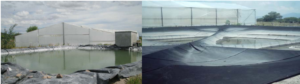
Figura 42. Depósito para abastecimiento de agua en el sistema.
