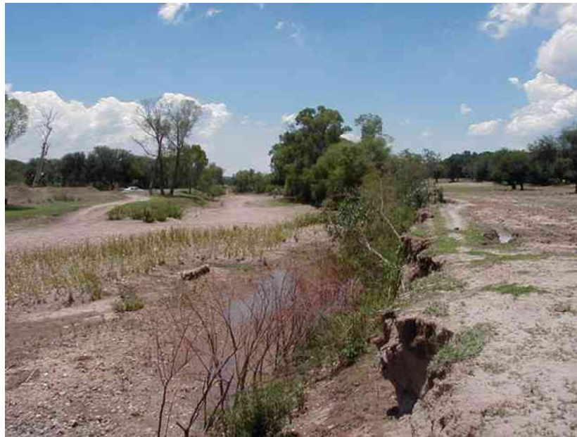
Figura 53. Erosión en paredes del río por efecto de acumulación de material y ausencia de zona de amortiguamiento. Al lado izquierdo se ubica la grava acumulada, zona de estudio, microcuenca Cruz del Palmar (2006)
