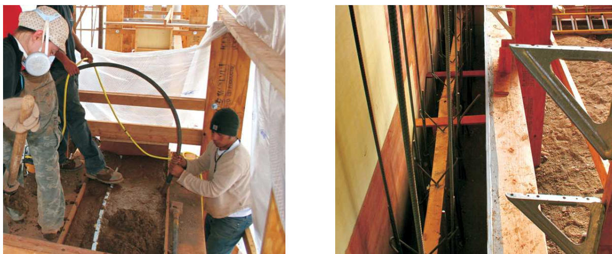
Fig. 3.5.2.2.10. Detalle del muro en la Biblioteca Sublette County. Fuente: Carney Architects (Bestraten et al. , 2011).
