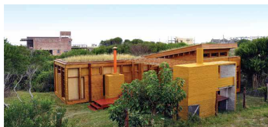
Fig. 3.5.2.2.12. Vista exterior de vivienda bloques de tierra alivianada, revestimiento de madera y techos verdes en Punta Rubia (Rocha) - Arq. Javier Márquez, 2006. Imagen: I. Ferrari. (Ferreiro, 2013).
