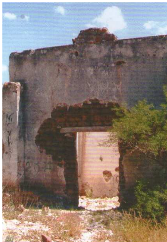
Fig. 3.5.2.1.34. Capilla en Granjeno, Tolimán, con muros de adobe (Secretaría de Desarrollo Urbano y Obras Públicas, Dirección de Sitios y Monumentos de Querétaro, 2009).
