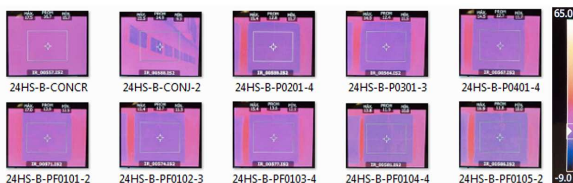
Fig. 5.4.1.2.19. Imagen termográfica de los diferentes tipos de paneles tomada a las 06:00pm del día 21/03/2015
