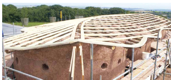
Fig. 3.5.2.2.11. Muros de cob y cubierta captadora de energía solar termica en el Pabellon de Servicios del Eden Project, cornwall, Reino Unido. Fuente: Abey Smallcombe (Bestraten et al. , 2011).
