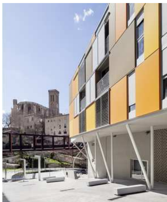
Fig. 3.4.2.8. Bloque de viviendas industrializadas en Manresa de Pich-Aguilera.
