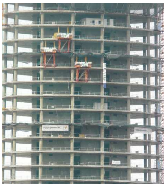
Fig. 3.3.3.1 Edificio en altura en Sevilla con estructura de concreto.
