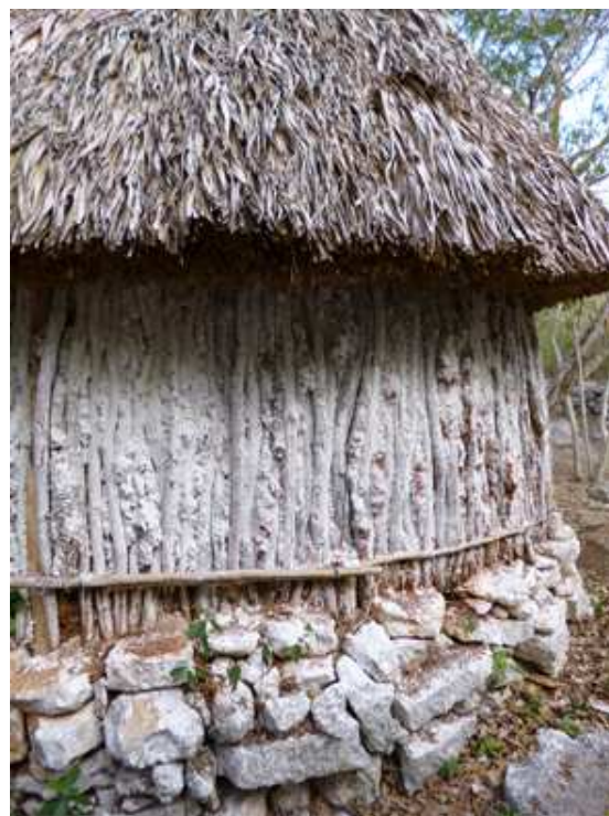
Fig. 3.5.2.1.80. Acabado exterior en cal en vivienda tradicional maya, Yucatán.
