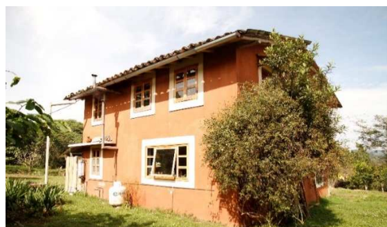
Fig. 3.5.2.1.115. Construcción en tierra en Las Cañadas. Fuente: Varun Thautam
