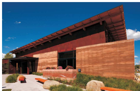
Fig. 3.5.2.2.9. Muros de tapial en la Biblioteca Sublette County, Pinedale, Wyoming, EE. UU. Fuente: Carney Architects (Bestraten et al. , 2011).
