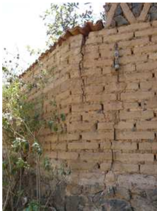
Fig. 3.5.2.1.51. Muro desarrollado con la técnica de adobe en Amatlán
