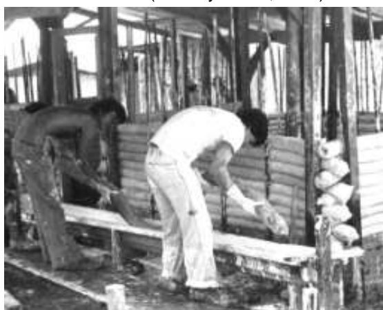
Fig. 3.5.2.2.1. Construcción con mangueras rellenas de barro. (Minke y Mhkle, 2001).
