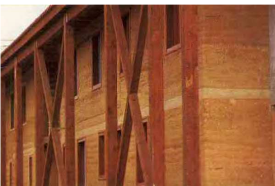
Fig. 3.5.2.1.97. Construcciones experimentales contemporáneas con técnica de tapial en Craterre, Francia (Barbeta, 2002).
