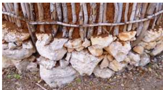
Fig. 3.5.2.1.74. Murete base del muro de bahareque con piedra caliza en vivienda tradicional maya, Yucatán.
