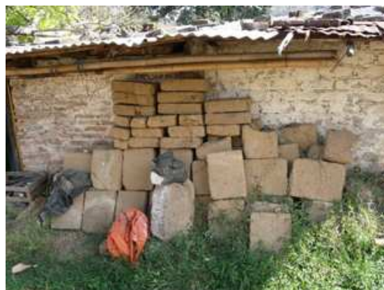
Fig. 3.5.2.1.50. Muro desarrollado con la técnica de adobe en Amatlán.
