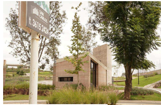
Fig. 3.5.2.1.117. Construcción con tapial. Tierra Compactada Arquitectos.
