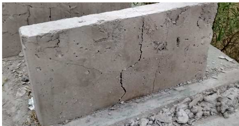
Fig. 5.4.1. Paneles PF0101 con fracturas y grietas por contracción/retracción
