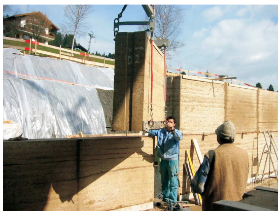
Fig. 3.5.2.3.40. Fabricación de paneles de tapial industrializados (Von Mag y Rauch, 2011).
