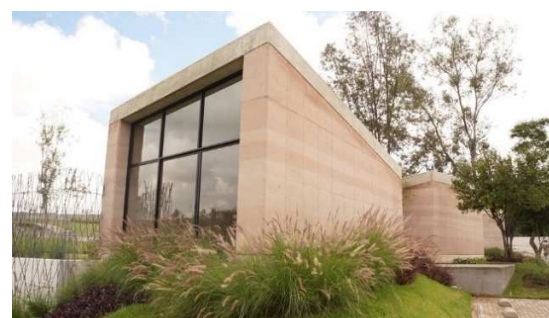
Fig. 3.5.2.1.120. Construcción con tapial. Tierra Compactada Arquitectos.
