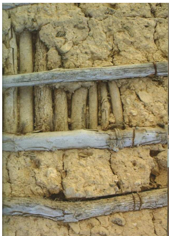
Fig. 3.5.2.1.46. Detalle de la técnica de enjarre o bajareque ("De tierra y varas. Una muestra de arquitectura vernácula en la Sierra Gorda de Querétaro", Secretaría de Desarrollo Urbano y Obras Públicas de Querétaro, Querétaro, 2009).
