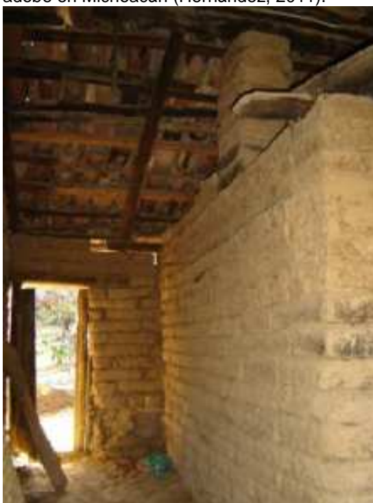
Fig. 3.5.2.1.55. Muro construido con técnica de adobe en Michoacán (Hernández, 2011).
