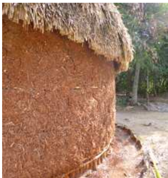
Fig. 3.5.2.1.77. Exterior de muro de bahareque en vivienda tradicional maya, Yucatán.
