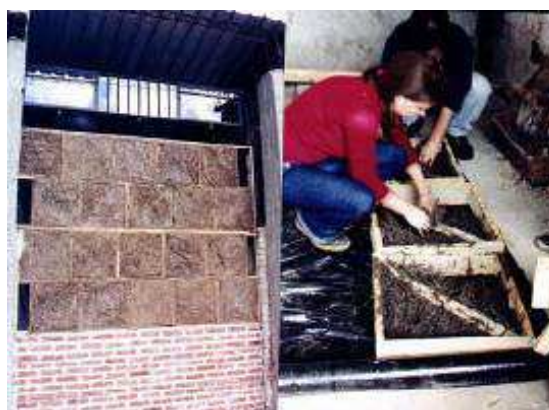
Fig. 3.5.2.3.20. Proceso constructivo con panel semiprefabricado. Arq. José Luis Mazzeo
