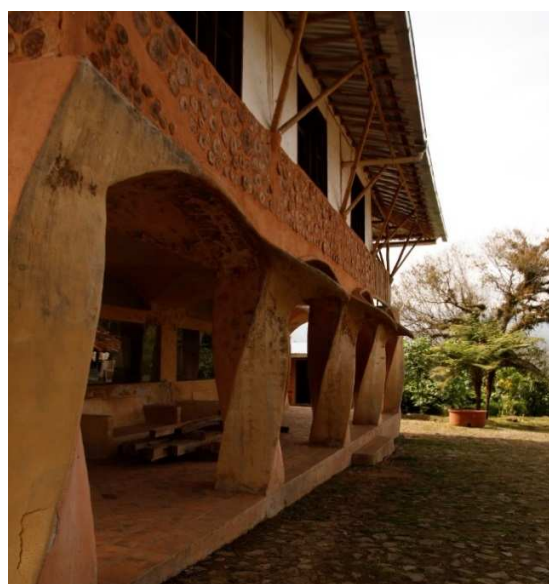
Fig. 3.5.2.1.113. Construcción en tierra en Las Cañadas. Fuente: Varun Thautam.
