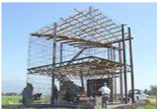
Fig. 3.5.2.3.13. Casa Batuco. Marcelo Cortés. http://www.marcelocortes.cl/proyectos/proyecto_descripcion.php?id=208
