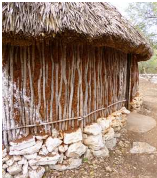
Fig. 3.5.2.1.76. Trama de ramas base de la técnica de Bahareque, con relleno de barro, en vivienda tradicional maya, Yucatán.
