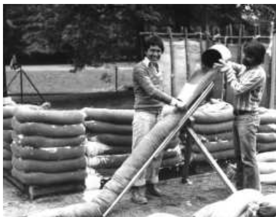
Fig. 3.5.2.2.1. Construcción con mangueras rellenas de barro. (Minke y Mhkle, 2001).
