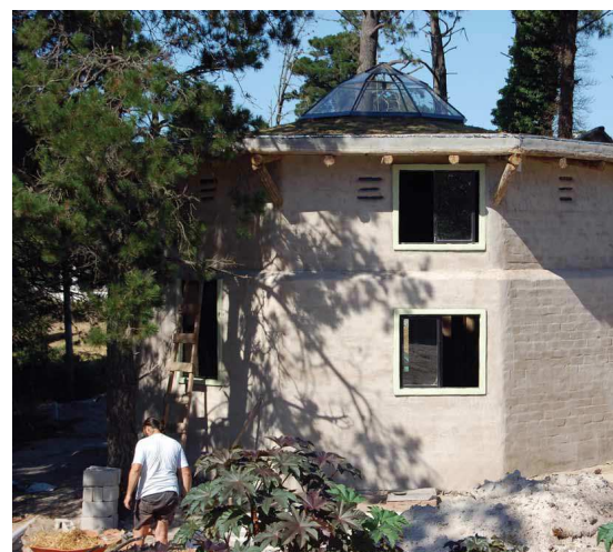
Fig. 3.5.2.1.105. Casa en Solymar. Técnicas: BTC muro doble de 36 cm de espesor; paneles de fajina y techos verdes. December, 2010 – A home in Solymar – Techniques: Double-thick CEB wall (36 cm), lath panels & green roof (Rosario. 2012).
