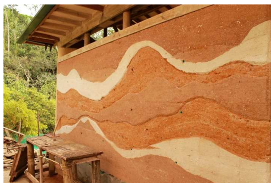
Fig. 3.5.2.1.102. Casa Mila. Construcción con técnica de tapial. Escala Urbana Arquitectura.
