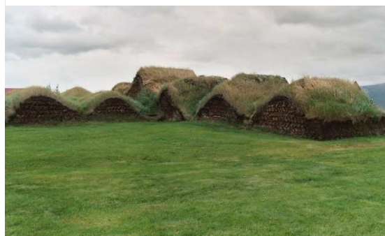
Fig. 3.5.4.6.9. Construcciones con bloques de turba.
