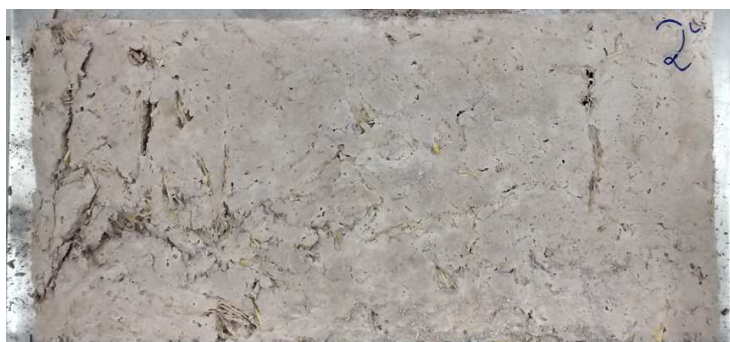
Fig. 5.4.1.1.14. Imagen de las fisuras ocasionadas en la prueba de compresión de uno de los paneles tipo PF0103
