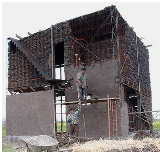
Fig. 3.5.2.3.14. Casa Batuco. Marcelo Cortés. http://www.marcelocortes.cl/proyectos/proyecto_descripcion.php?id=208
