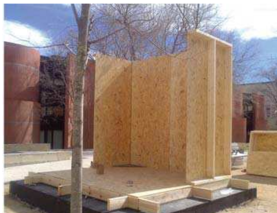
Fig. 3.5.2.2.14. Preparación de encofrado perdido (Estévez y Martín-Lara, 2013)
