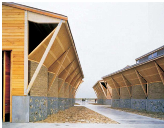
Fig. 3.5.2.1.104. Muros de adobe protegidos por los aleros de la cubierta y los zócalos de hormigón y piedra en la Bodega Los Robles, San Fernando, Chile. Fuente: José Cruz Ovalle
