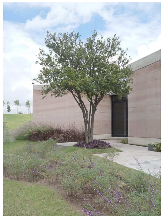
Fig. 3.5.2.1.119. Construcción con tapial. Tierra Compactada Arquitectos.
