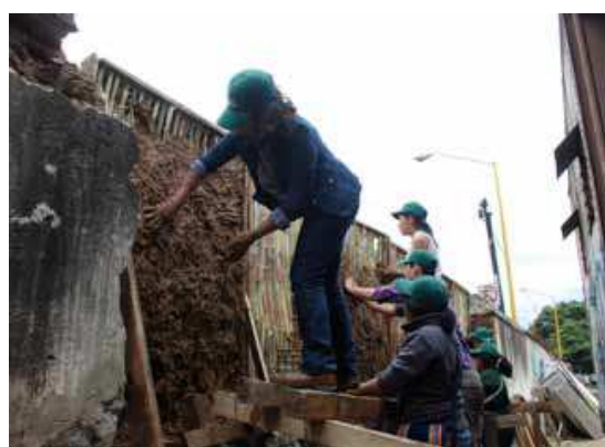
Fig. 3.5.2.3.24. Puesta en obra de panel prefabricado de quincha.
