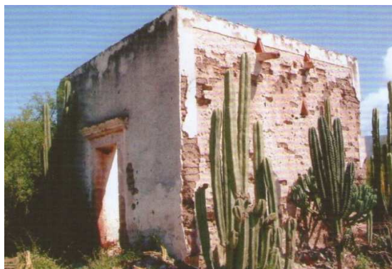
Fig. 3.5.2.1.36. Capilla en Granjeno, Tolimán, con muros de adobe (Secretaría de Desarrollo Urbano y Obras Públicas, Dirección de Sitios y Monumentos de Querétaro, 2009).
