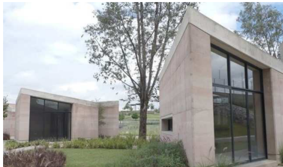
Fig. 3.5.2.1.120. Construcción con tapial. Tierra Compactada Arquitectos.
