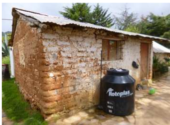
Fig. 3.5.2.1.44. Vivienda construida con técnica de Adobe.
