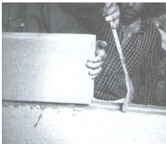
Fig. 3.5.2.3.31. Colocación de panel Karphosit (Minke, 1998).
