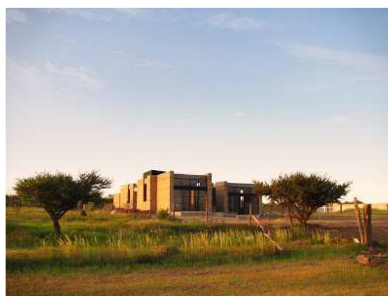
Fig. 3.5.2.1.121. Construcción con tapial. Tierra Compactada Arquitectos. Fotografías: Gabriel Pernaletе Blanco http://blogs.edificando.es/articulos/arquitectura/3343-casa-de-tierra--menci%C3%B3n-honor%C3%ADfica-en-la-xii-bam..html
