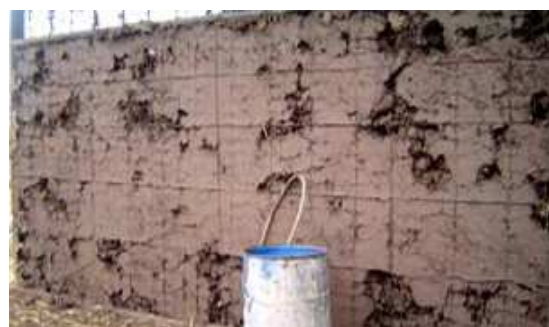
Fig. 3.5.2.3.11. Detalle constructivo Tecnobarro. Marcelo Cortés. http://www.marcelocortes.cl/proyectos/proyecto_descripcion.php?id=208
