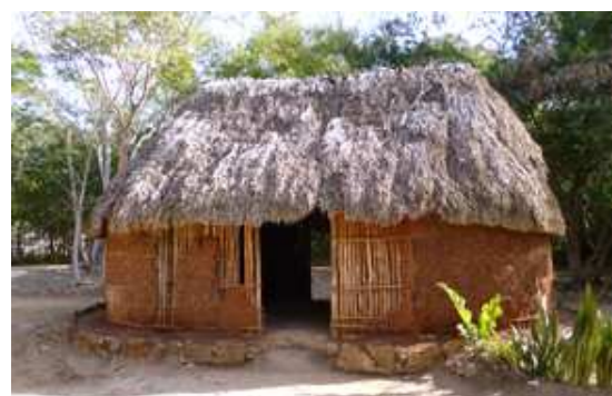
Fig. 3.5.2.1.75. Trama de ramas base de la técnica de Bahareque, con relleno de barro, en vivienda tradicional maya, Yucatán.
