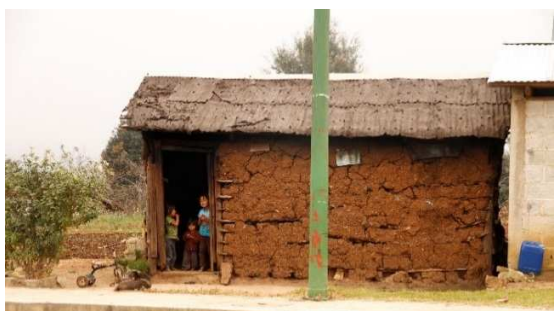
Fig. 3.5.2.1.70. Construcción con bahareque en San Juan Chamula, Chiapas. Fuente: Varun Thautam.
