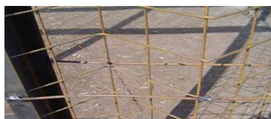
Fig. 3.5.2.3.9. Detalle constructivo Tecnobarro. Marcelo Cortés. http://www.marcelocortes.cl/proyectos/proyecto_descripcion.php?id=208
