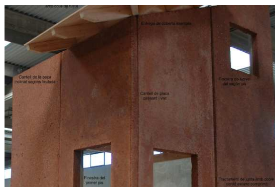
Fig. 3.5.2.3.37. Panel prefabricado mixto de paja y cáñamo (www.cannabric.com)
