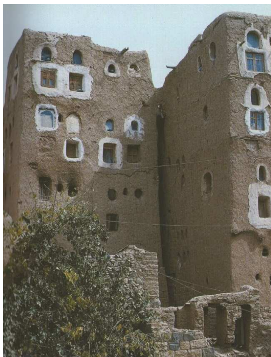
Fig. 3.5.2.1.5. Construcción con tierra en Yemen (May, 2011).
