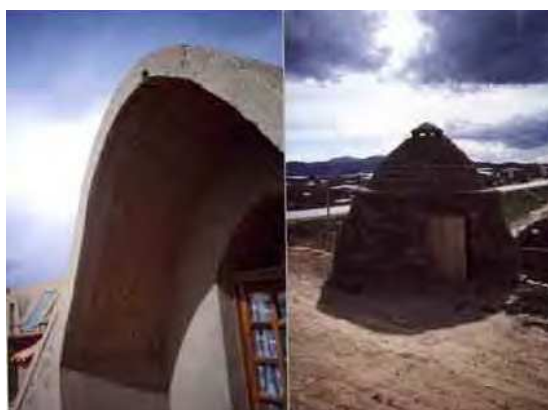
Fig. 3.5.2.1.103. Laka-Uta de viviendas bioclimáticas de adobe, en Lahuachaca, Bolivia (Barbeta, 2002).
