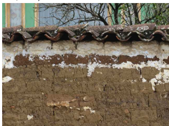
Fig. 3.5.2.1.59. Restos de la pintura de cal que protege a los adobes en las fachadas. Fuente: Jaqueline Jiménez (Jiménez et al , 2013).
