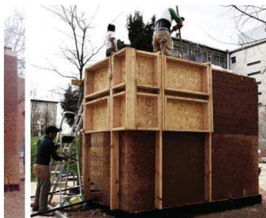
Fig. 3.5.2.2.17. Muro de tapial en construcción (Estévez y Martín-Lara, 2013).
