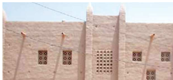
Fig. 3.5.2.1.93. Muros de adobe y aberturas con celosias en el edificio para la asociación Yeredeme, Mopti, Mali. Fuente: Fernando Martin
