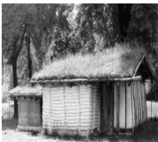
Fig. 3.5.2.2.3. Construcción con mangueras rellenas de barro. (Minke y Mhkle, 2001).
