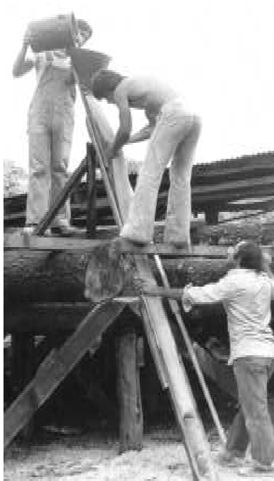
Fig. 3.5.2.2.3. Construcción con mangueras rellenas de barro. (Minke y Mhkle, 2001).
