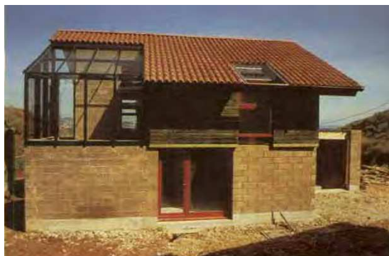
Fig. 3.5.2.1.98. Construcciones contemporáneas experimentales con técnica de btc en Craterre, Francia (Barbeta, 2002).
