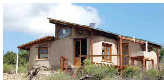
Fig. 3.5.2.3.19. Técnicas: BTC muro doble espesor 36 cm; paneles de fajina; techo verde; techo madera; torta de barro y teja asfáltica. Obra terminada. (Rosario, 2012).
