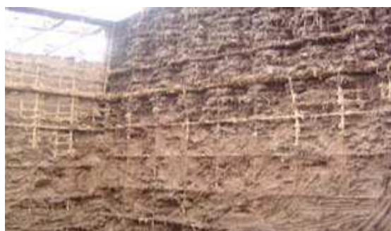
Fig. 3.5.2.3.11. Detalle constructivo Tecnobarro. Marcelo Cortés. http://www.marcelocortes.cl/proyectos/proyecto_descripcion.php?id=208
