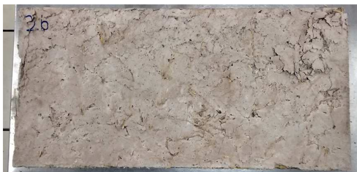
Fig. 5.4.1.1.13. Imagen de las fisuras ocasionadas en la prueba de compresión de uno de los paneles tipo PF0103
