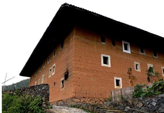
Fig. 3.5.2.1.17. Tulou de Fujian, china http://en.wikipedia.org/wiki/Fujian_Tulou#/medi
