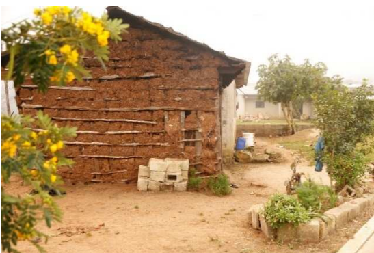
Fig. 3.5.2.1.71. Construcción con bahareque en San Juan Chamula, Chiapas. Fuente: Varun Thautam
