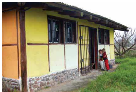
Fig. 3.5.2.3.22. Vivienda construida con panel prefabricado. De Fajina (Rosario, 2012).
