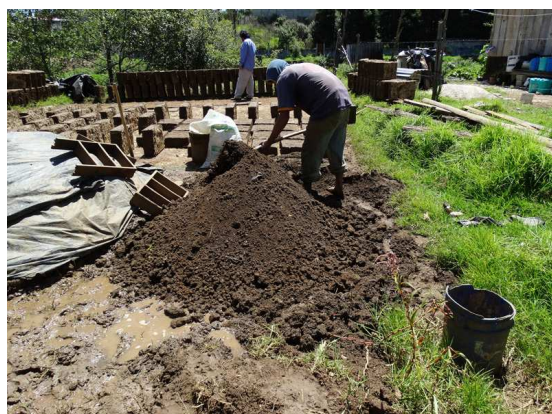
Fig. 3.5.2.1.112. Mezclado de la tierra y la arena en seco. Fuente: Jaqueline Jiménez. (Jiménez et al. , 2013).
