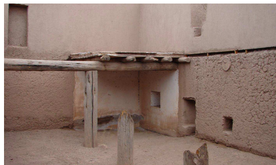
Fig. 3.5.2.1.32. Patio de vivienda prehispánica en tierra en Paquimé (Md4arquitectura bioclimática).
