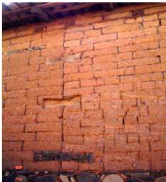
Fig. 3.5.2.1.54. Muro construido con técnica de adobe en Michoacán (Hernández, 2011).
