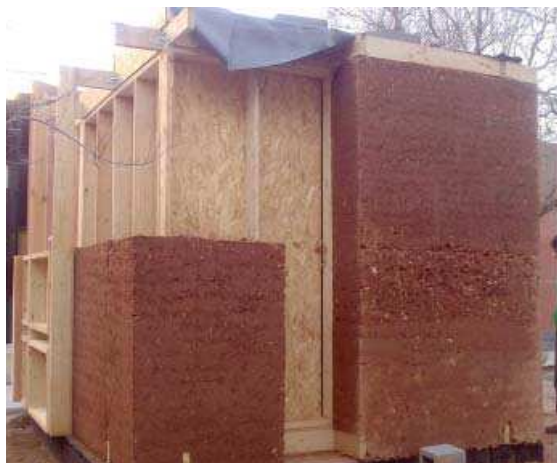
Fig. 3.5.2.2.19. Muro de tapial en construcción (Estévez y Martín-Lara, 2013).
