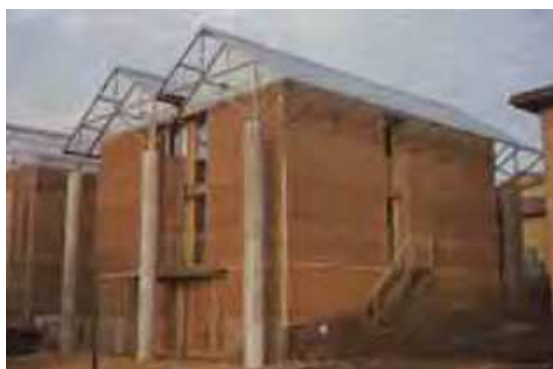
Fig. 3.5.2.1.100. Construcciones contemporáneas experimentales con técnica de btc en Craterre, Francia (Barbeta, 2002).
