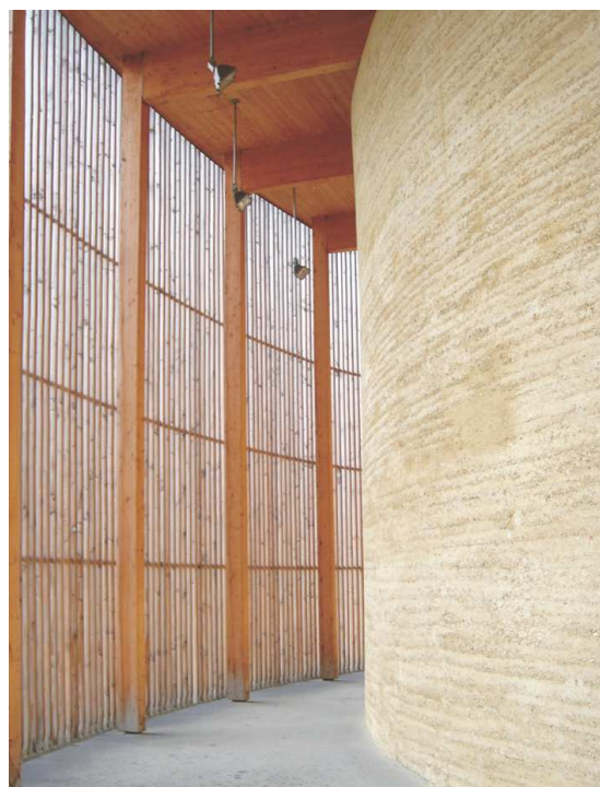
Fig. 3.5.2.2.4. Capilla de la Reconciliación. Arquitectos: Reiterman y Sassenroth. Construcción del tapial: Lehm Ton Erde, Martin Rauch (Bestraten, 2001).
