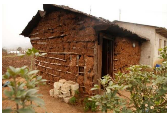
Fig. 3.5.2.1.68. Construcción con bahareque en San Juan Chamula, Chiapas. Fuente: Varun Thautam.
