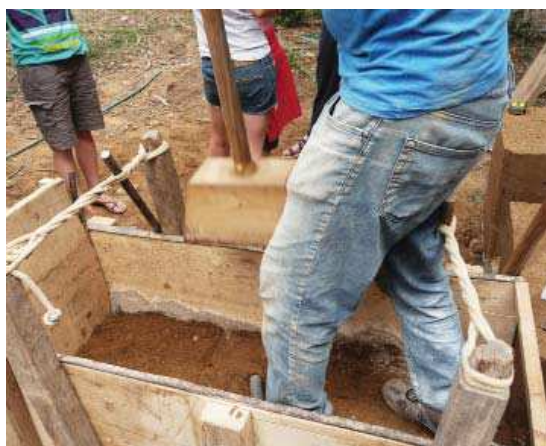
Fig. 3.5.2.2.16. Muro de tapial en construcción (Estévez y Martín-Lara, 2013).
