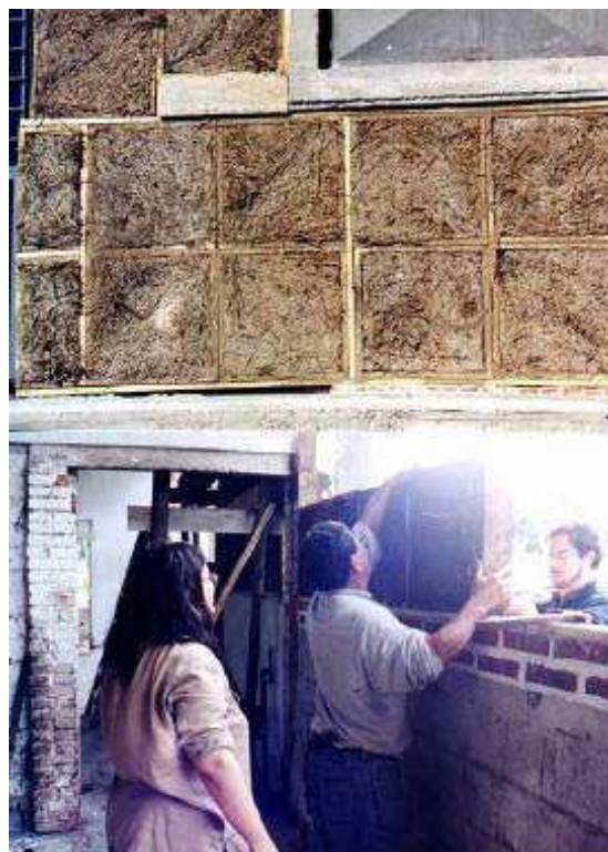
Fig. 3.5.2.3.21. Proceso constructivo con panel semiprefabricado. Arq. José Luis Mazzeo.
