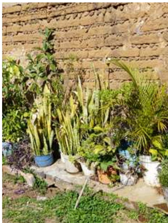
Fig. 3.5.2.1.49. Muro desarrollado con la técnica de adobe en Tepoztlán.
