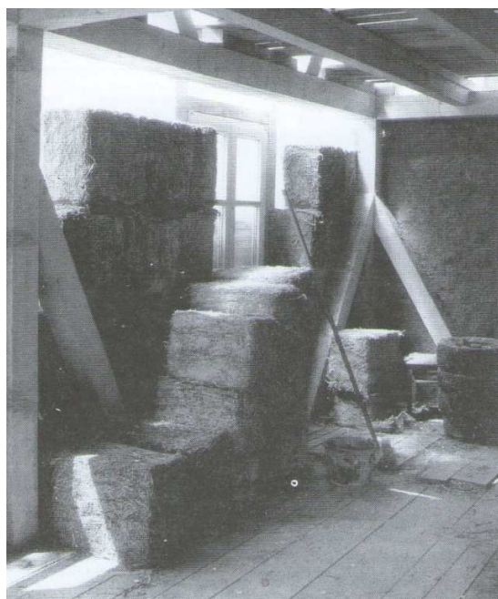
Fig. 3.5.2.3.29. Muros de bloques grandes de barro alivianado con paja (Minke, 1998)
