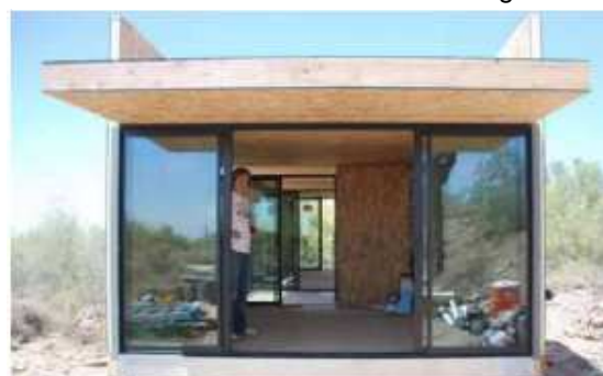
Fig. 3.4.2.9. Imagen del proyecto Taliesin Mod.FabTM construido con elementos prefabricados.
