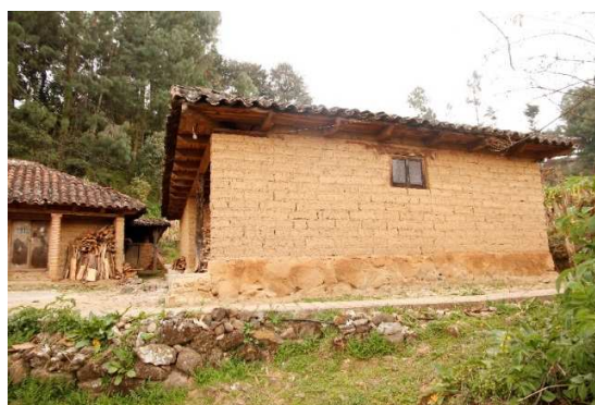
Fig. 3.5.2.1.69. Construcción con adobe en San Juan Chamula, Chiapas. Fuente: Varun Thautam.
