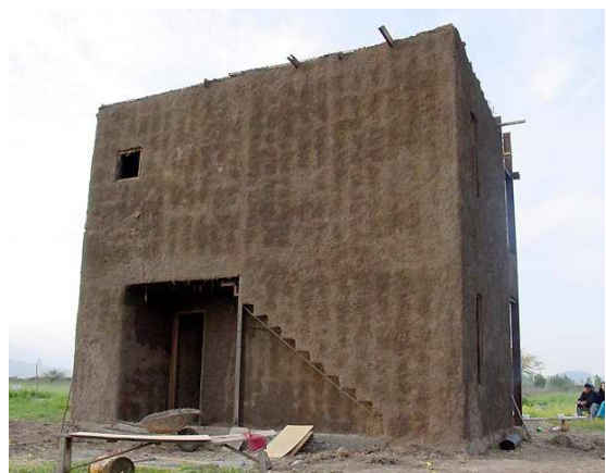
Fig. 3.5.2.3.16. Casa Batuco. Marcelo Cortés. http://www.marcelocortes.cl/proyectos/proyecto_descripcion.php?id=208
