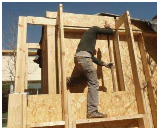
Fig. 3.5.2.2.15. Muro de tapial en construcción (Estévez y Martín-Lara, 2013).
