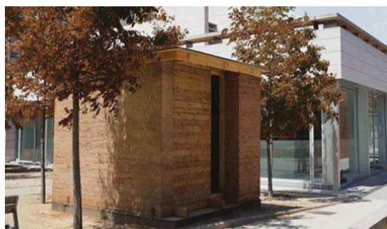
Fig. 3.5.2.2.18. Prototipo ya construido e instrumentalizado para el estudio de su comportamiento termohigrométrico. Fuente: Allepuz, Poza. (Estévez y Martín-Lara, 2013).
