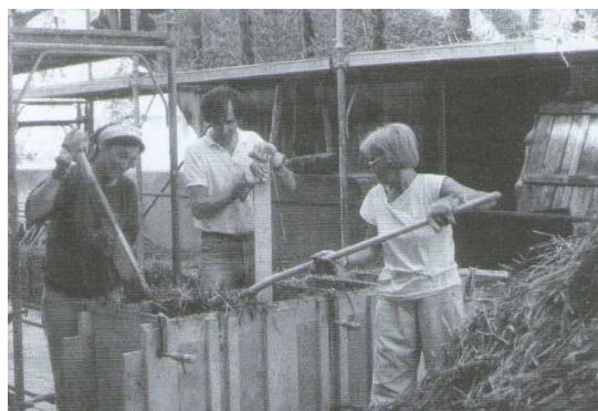
Fig. 3.5.2.3.30. Fabricación de bloques grandes de barro alivianado con paja (Minke, 1998)
