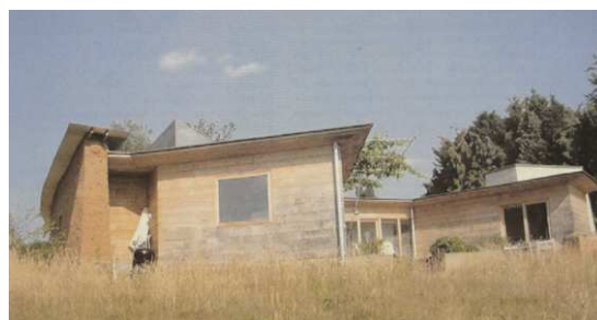
Fig. 3.5.4.6.10. Casa de adobe, Worcester, R. Unido.
