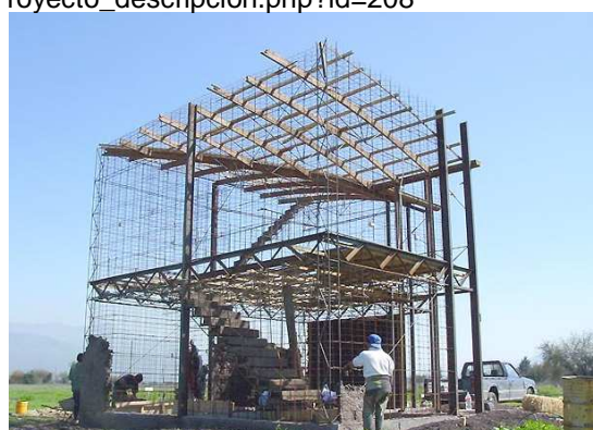
Fig. 3.5.2.3.15. Casa Batuco. Marcelo Cortés. http://www.marcelocortes.cl/proyectos/proyecto_descripcion.php?id=208
