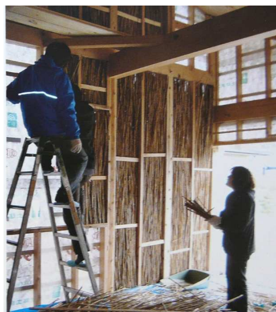
Fig. 3.5.4.6.7. Entramado de fibras vegetales rellenos con barro plástico.
