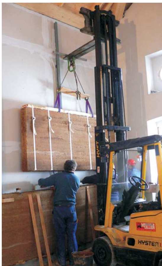
Fig. 3.5.2.3.41. Fabricación de paneles de tapial industrializados (Von Mag y Rauch, 2011).
