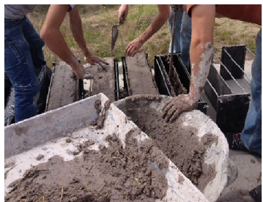
Fig. 4.5.1.9. Proceso de vaciado en moldes
