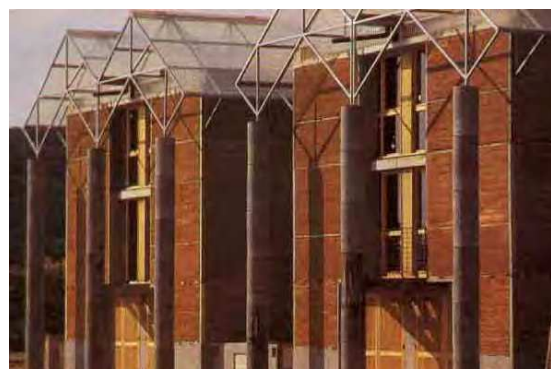
Fig. 3.5.2.1.101. Construcciones contemporáneas experimentales con técnica de btc en Craterre, Francia (Barbeta, 2002).
