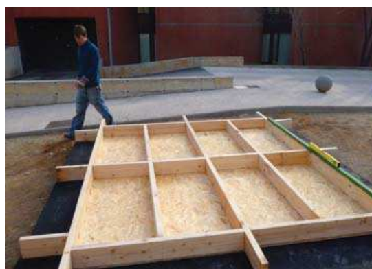
Fig. 3.5.2.2.13. Preparación de encofrado perdido (Estévez y Martín-Lara, 2013)
