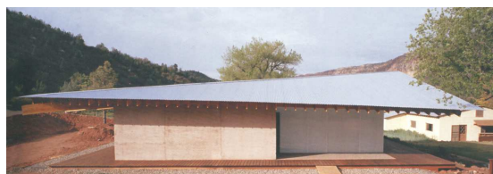
Fig. 3.5.2.2.8. Muros de tapial y cubierta paraboloides hiperbólicas en el Bodhi Mandala Zen Centre, Jemez Springs, Nuevo México. Imagen: Predock Frane Architects (Bestraten et al. , 2011).
