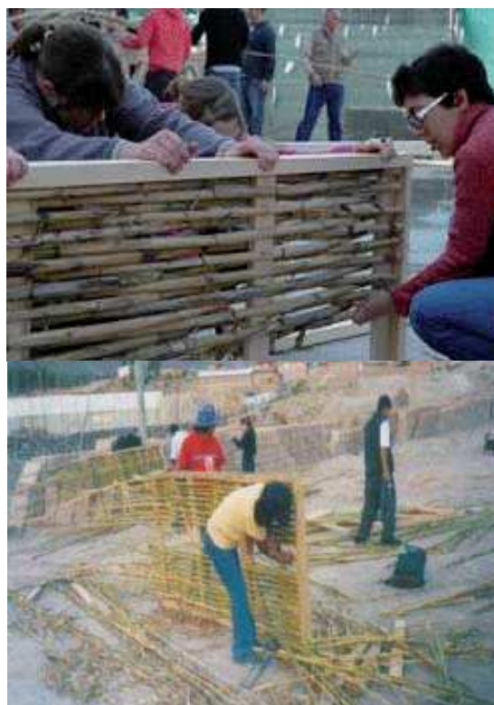
Fig. 3.5.2.3.23. Fabricación de panel prefabricado de quincha.
