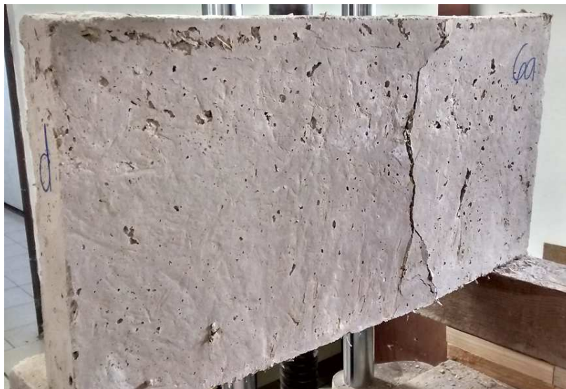
Fig. 5.4.1.1.23. Imagen de las fisuras ocasionadas en la prueba de flexión vertical de uno de los paneles PF0102
