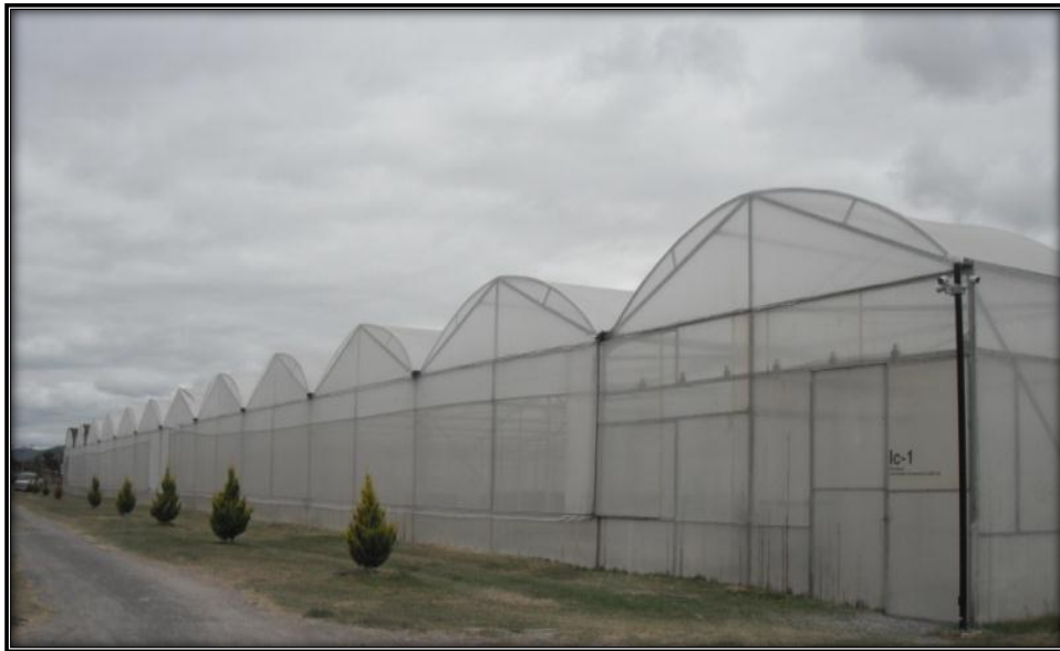
Figura 4.1 Invernadero 5600m 2 campus Amazcala, Facultad de Ingeniería UAQ.
