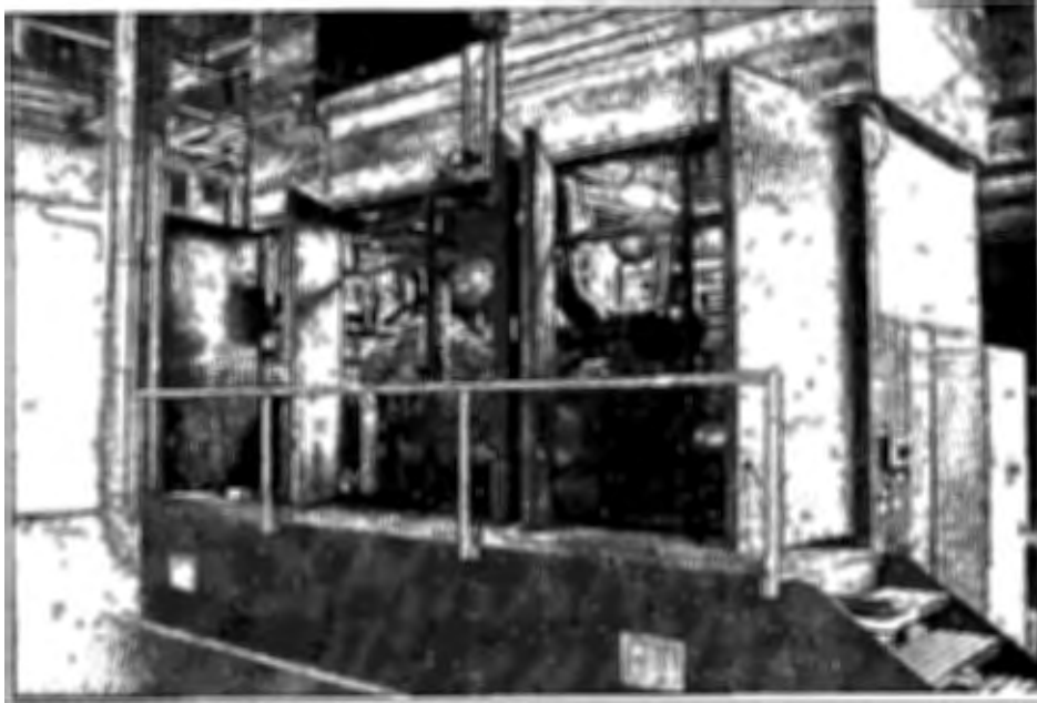
Fig. 1.7 Equipo de Cogeneración de Turbina de Gas Natural. Fuente: Cummins Inc.. www.cummins.com
