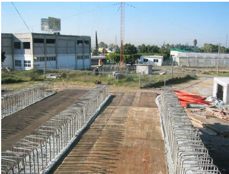
Figura B.13.- Arriba de la futura losa, inicia cimbra para recibir primera capa de acero de refuerzo de losa de reacción. (12 de Diciembre de 2006)
