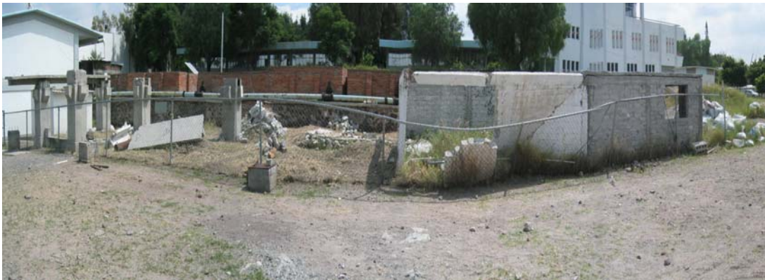
Figura 1. Instalaciones utilizadas para fines de docencia del área de estructuras
