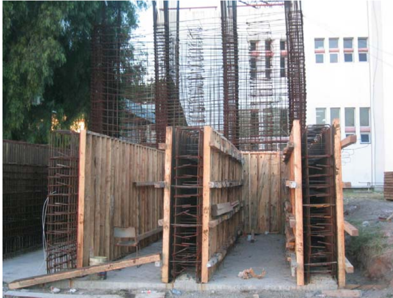
Figura B.10.- Inicia cimbrado para ETAPA 2, muros de sostenimiento (25 de Noviembre de 2006)
