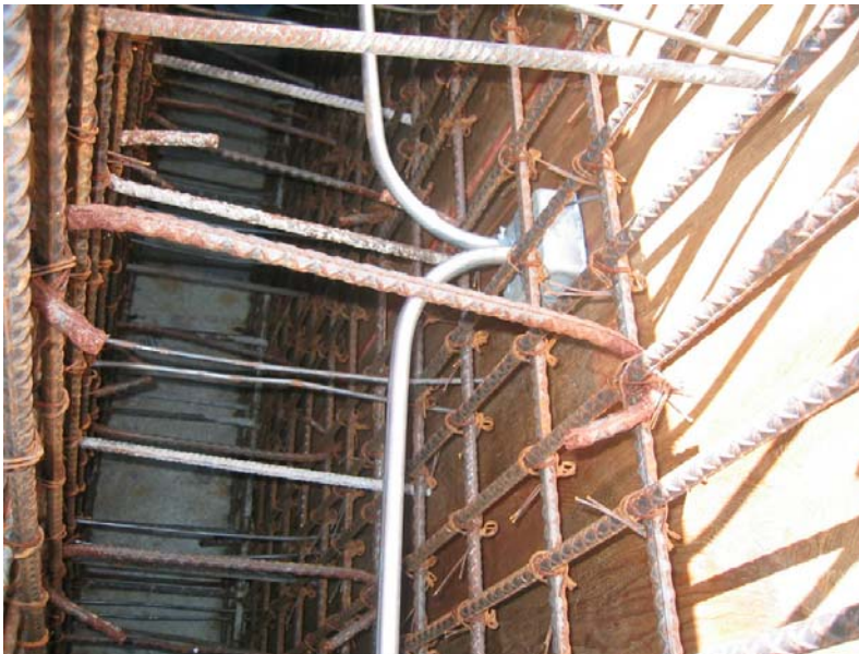
Figura B.11.- Tubería para recibir instalación eléctrica adosada a la cimbra (30 de Noviembre de 2006)
