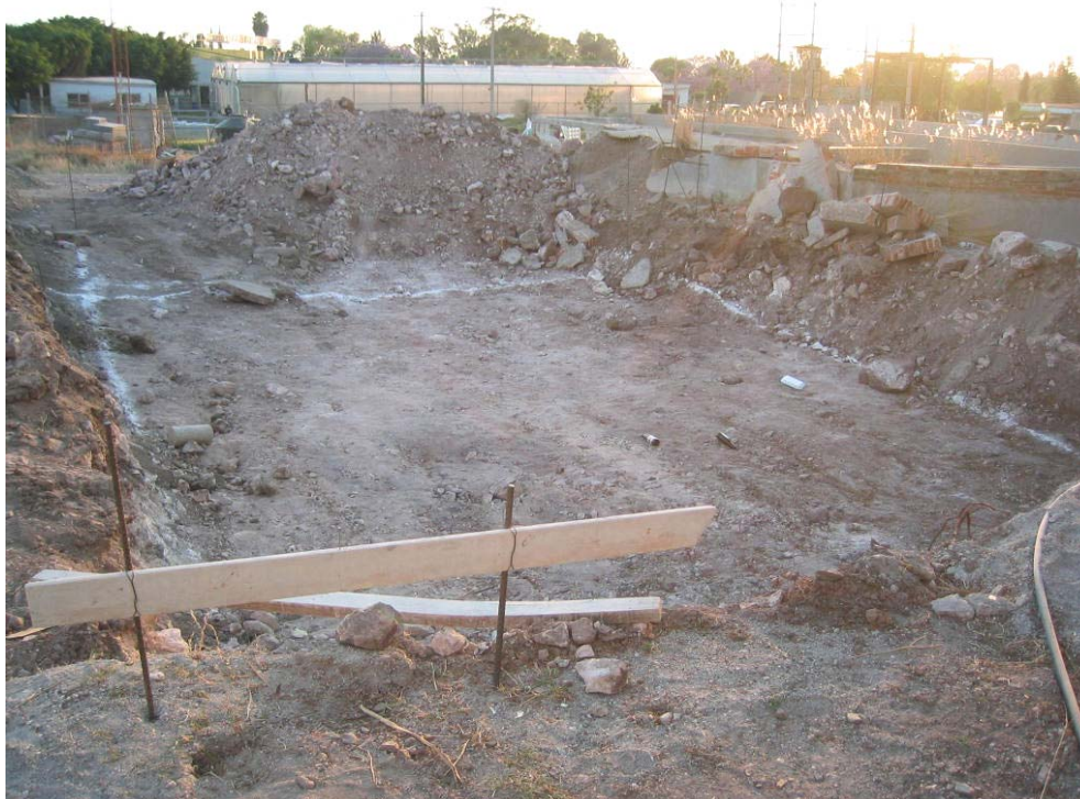
Figura 4.1.- Excavación para la cimentación del muro de reacción.
