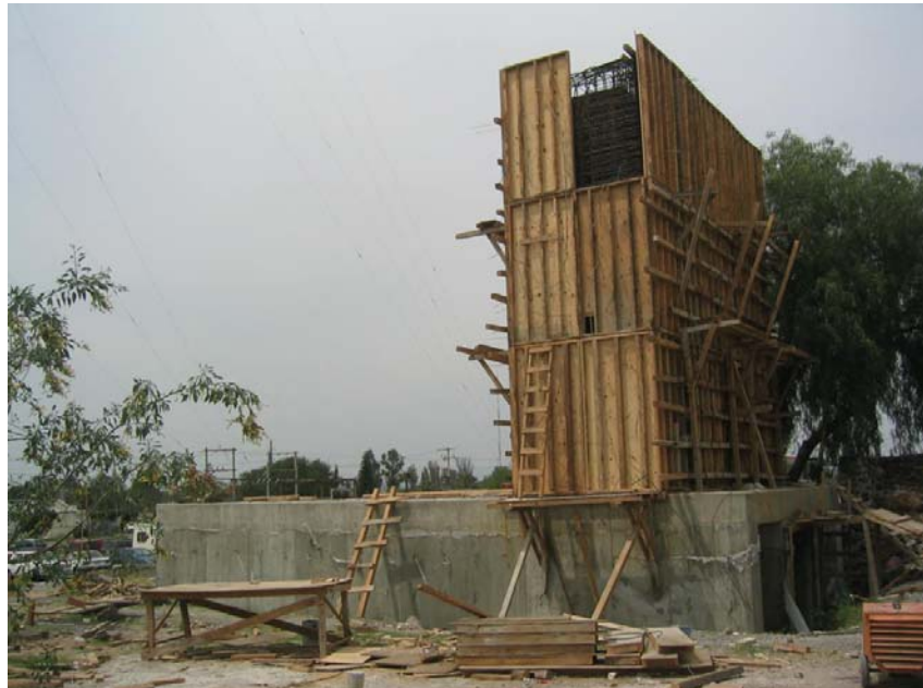
Figura B.25.- Finalización de cimbra para muro de reacción, aspecto general de proyecto (17 de Marzo de 2007)
