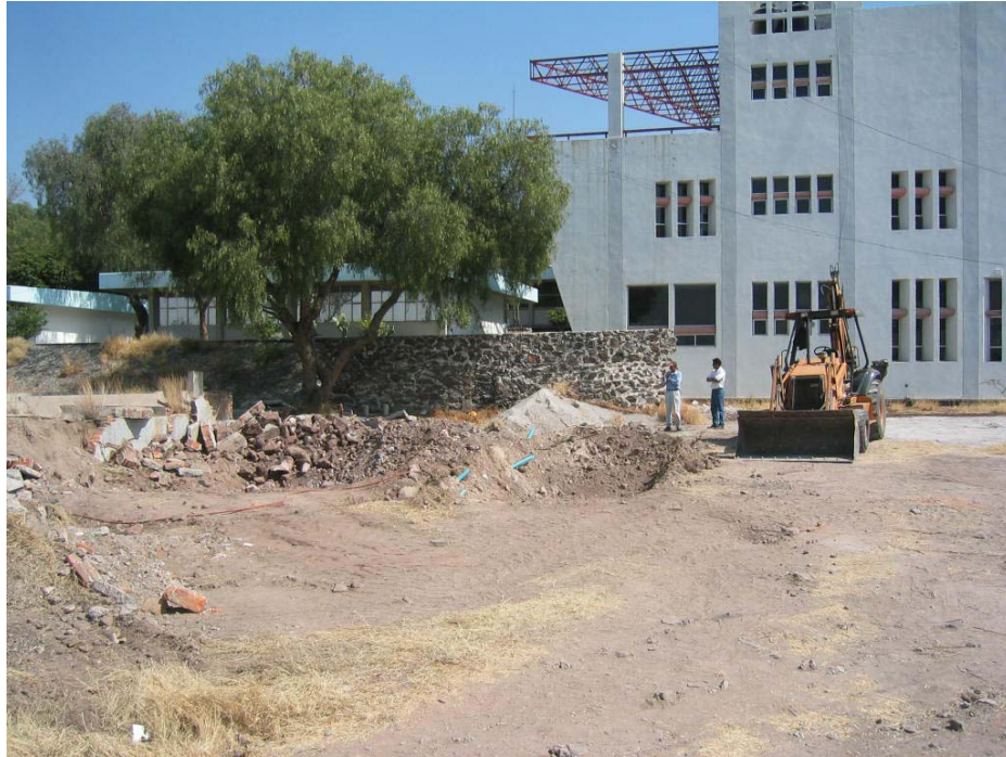
Figura 6.3.- Inicio de excavación para alojar la cimentación del muro.
