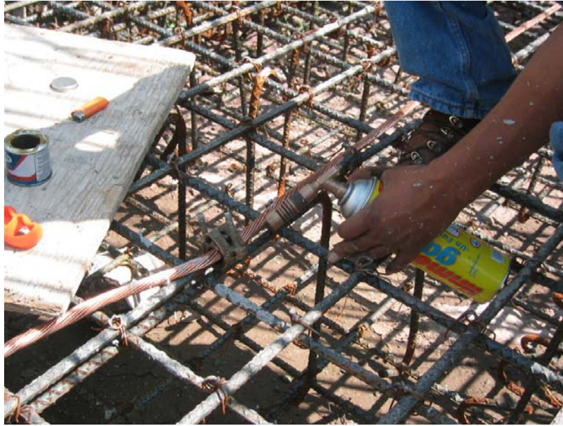
Figura B.8.- Instalación de tierras físicas para aterrizar estructura metálica (23 de Septiembre de 2008 por la mañana)
