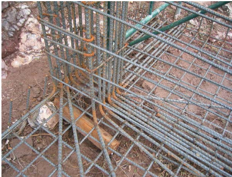
Figura B. 5.- Armandado base para muro de reacción (5 de Julio de 2005)
