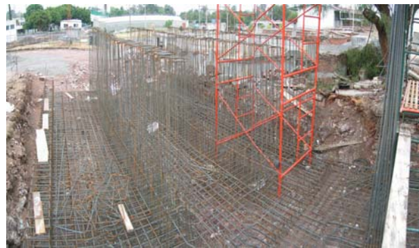
Figura C.1.- Armado del acero de refuerzo, muro de reacción FI-UAQ.
