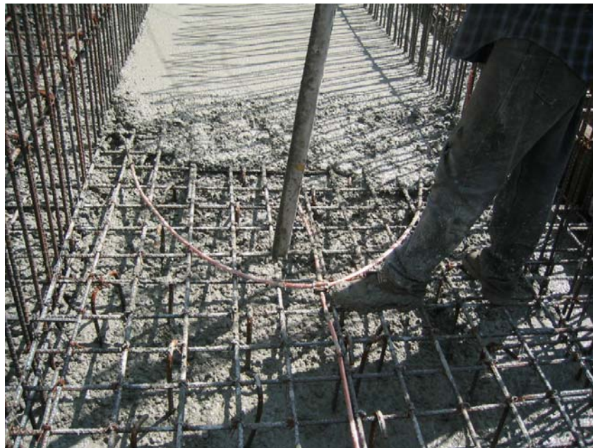
Figura B. 9.- Colado de la losa de cimentación (23 de Septiembre de 2005 por la tarde) FINAL DE ETAPA 1 (final de presupuesto inicial)
