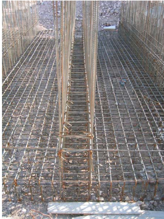
Figura B.4.- Acero de refuerzo para muros de sostenimiento (28 de Mayo de 2005)
