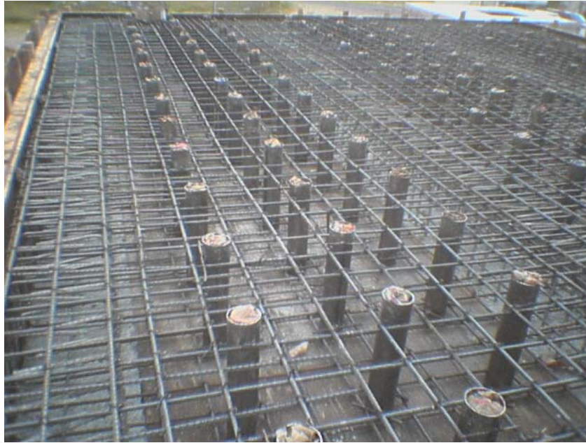
Figura B.16.- Muestra la segunda capa de acero de refuerzo para la losa de reacción así como el alojamiento (soldado a la estructura) de los agujeros pasantes (21 de Diciembre de 2006 un día antes del colado)
