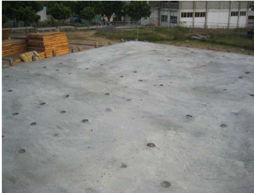
Figura B.18.- Fin de la ETAPA 2, aspecto general de la losa de reacción (22 de Diciembre de 2006 por la tarde)
