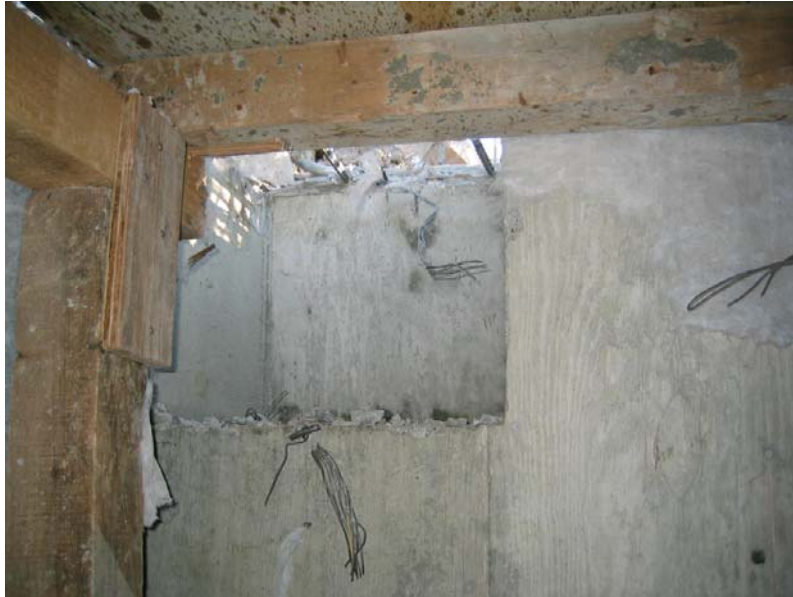
Figura B. 14.- Apuntalamiento inferior de la losa de reacción y hueco para recibir placa de postensado (12 de Diciembre de 2006)
