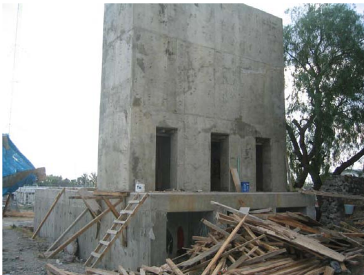
Figura B.27.- Panorama general posterior del muro de reacción, galerías verticales, inicio de limpieza de obra (19 de Mayo de 2008)
