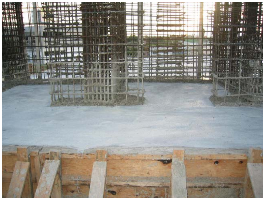
Figura B.16.- Muestra la segunda capa de acero de refuerzo para la losa de reacción así como el alojamiento (soldado a la estructura) de los agujeros pasantes (21 de Diciembre de 2006 un día antes del colado)
