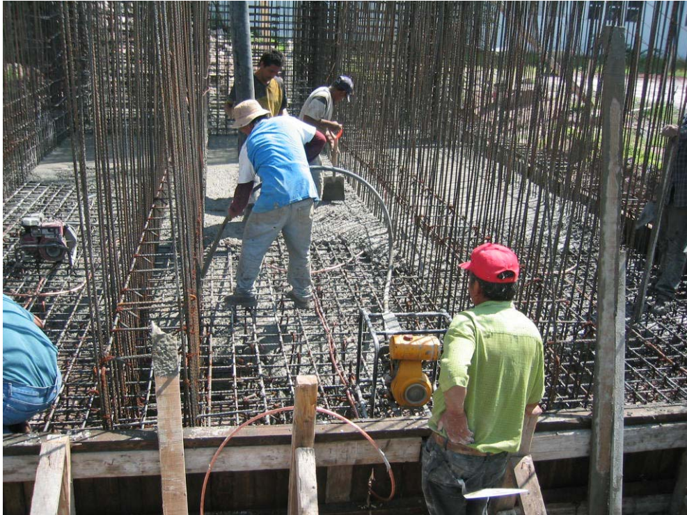
Figura 6.5.- Muestra el colado en la losa de cimentación.
