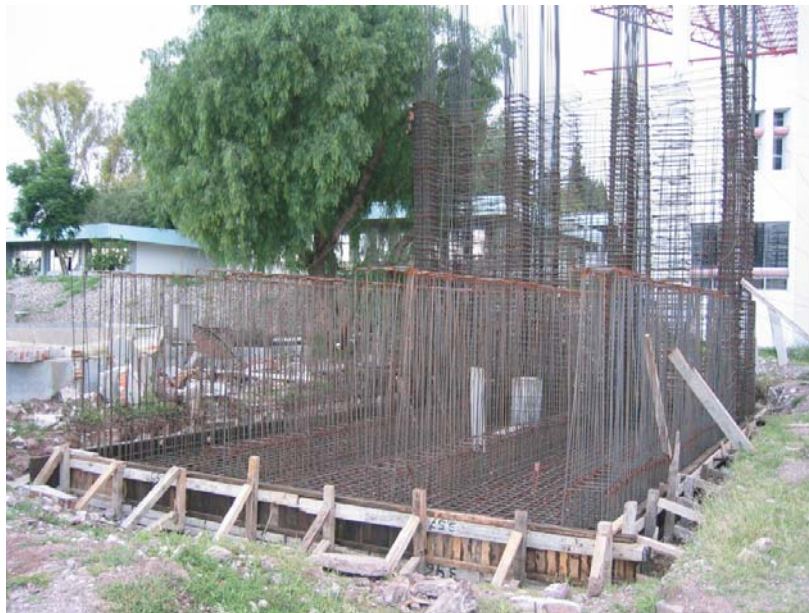
Figura B.7.- Inicia etapa de cimbrado para colar losa de cimentación (23 de Septiembre de 2008)
