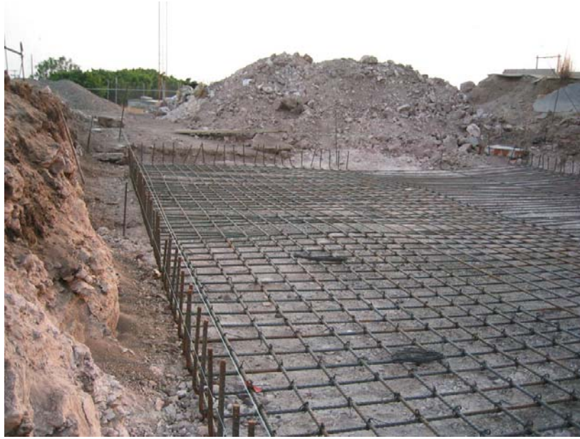
Figura B.2.- Armado de refuerzo para base de cimentación, primera capa (15 de Mayo 2005)
