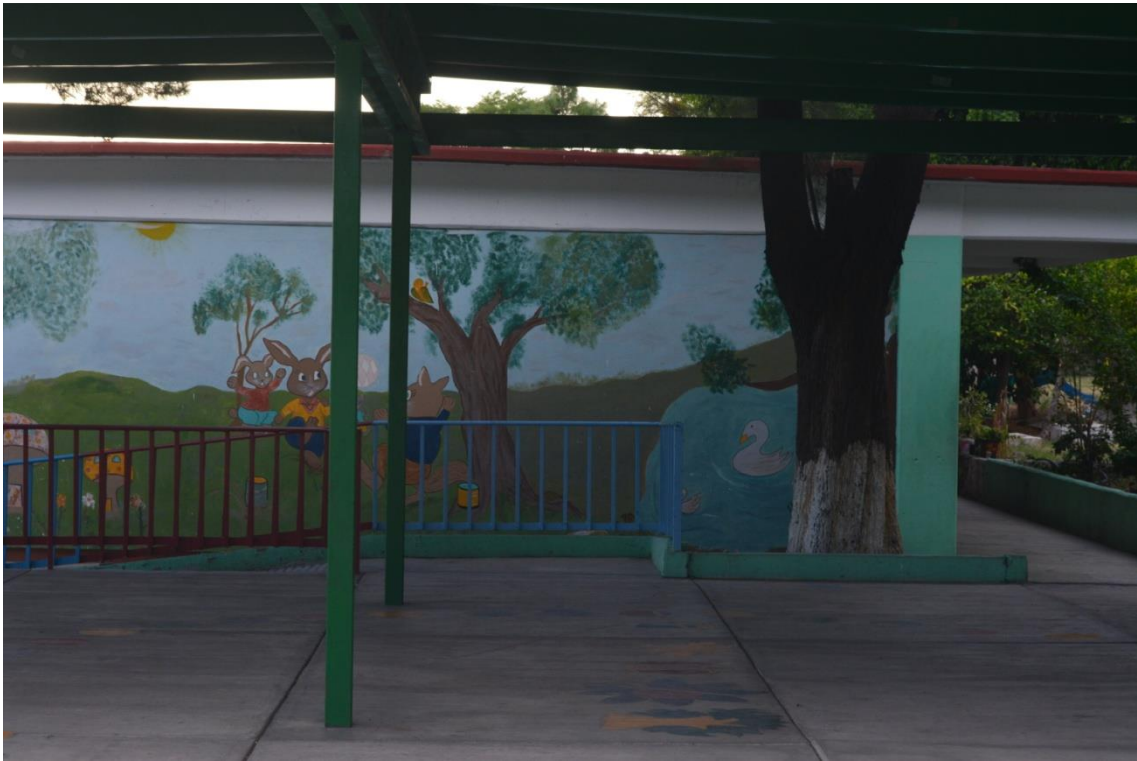
Figura 34: Patio central Fotografía Propia
