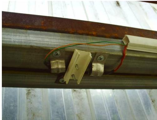
**Figura 5-3** Sensor Óptico Infrarrojo para la puerta exterior e interior.
