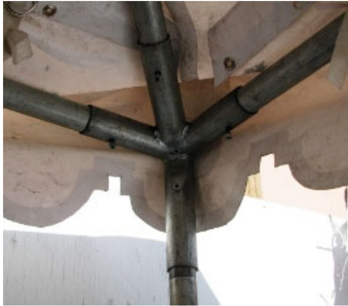
Fig. IV.12 Imagen de conexión de esquina de tienda provisional
