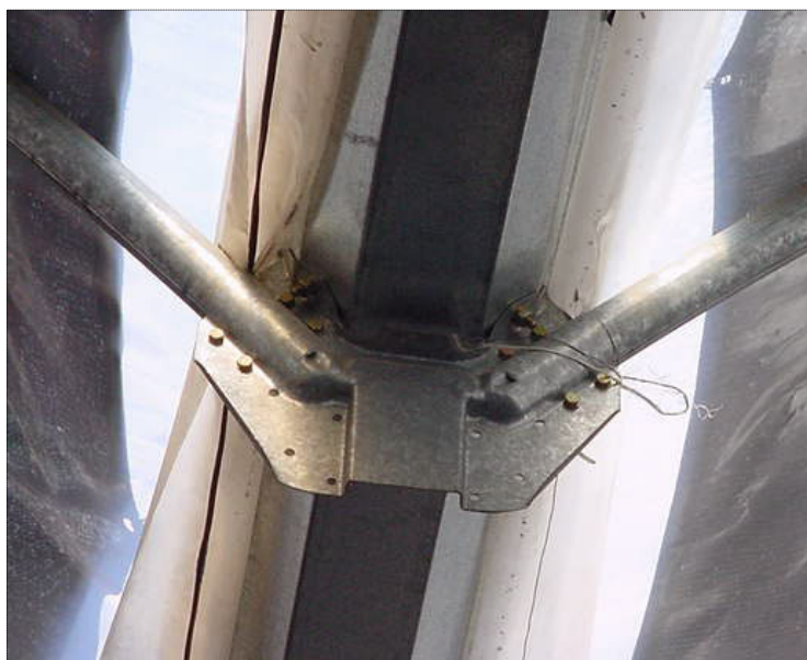
Fig. III.6. Conexión atornillada de un invernadero.
