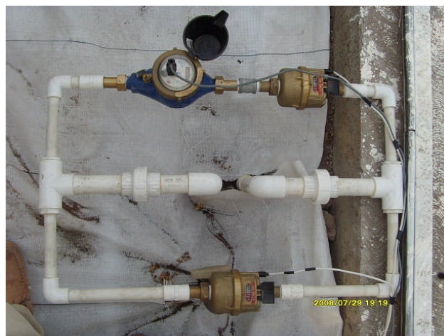
Figura 3.5.2.1 Instalación de medidores de flujo de agua
