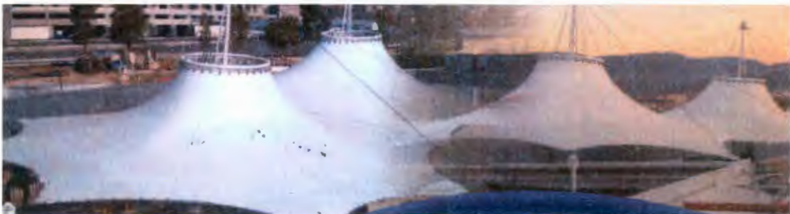
Fig 2.30 Centro de rehabilitación infantil (CRIQ)
