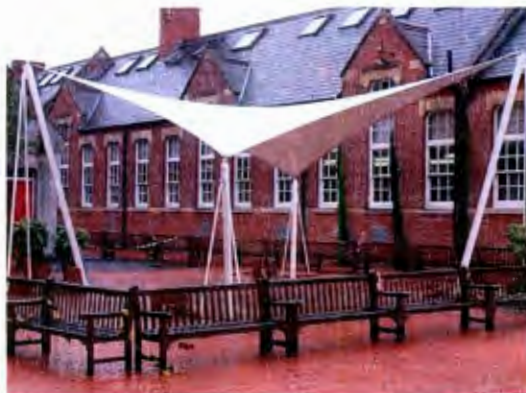
Fig 2.36 Forma Básica de Hypar a partir de un paraboloides hiperbólico
