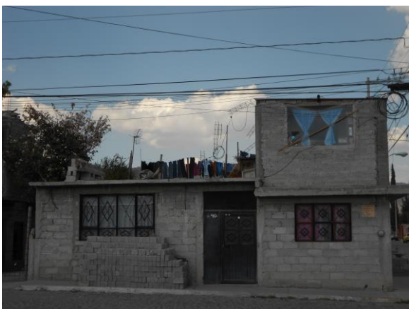
Casa de block de concreto y cemento Imagen No. 4
