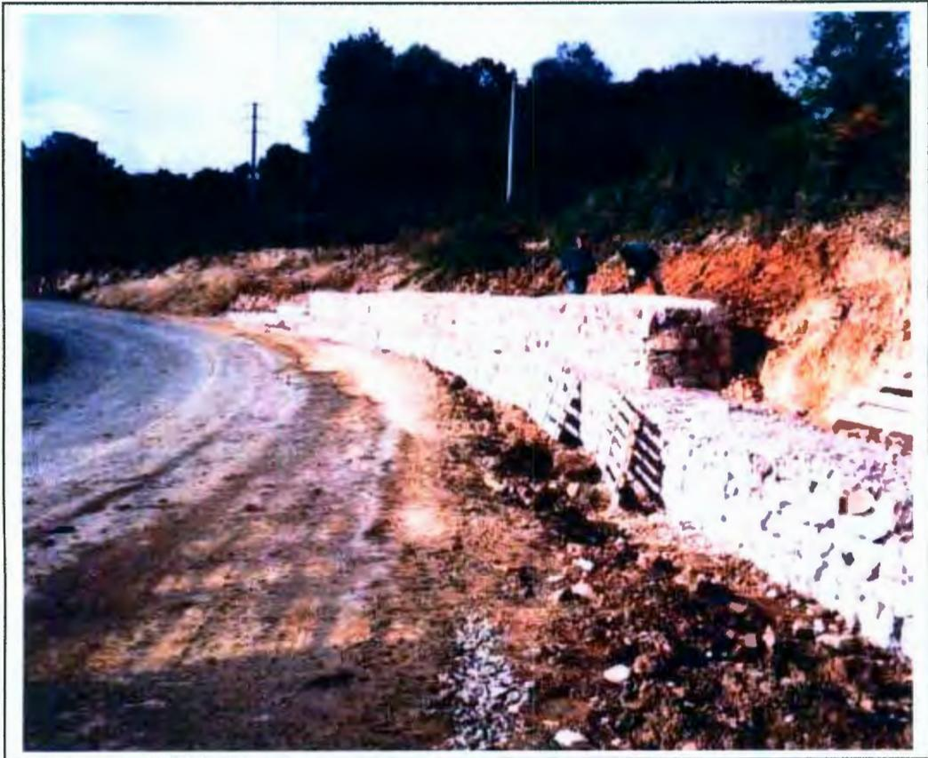
**Figura 3.6. construcción de un muro de contención con gaviones.**
