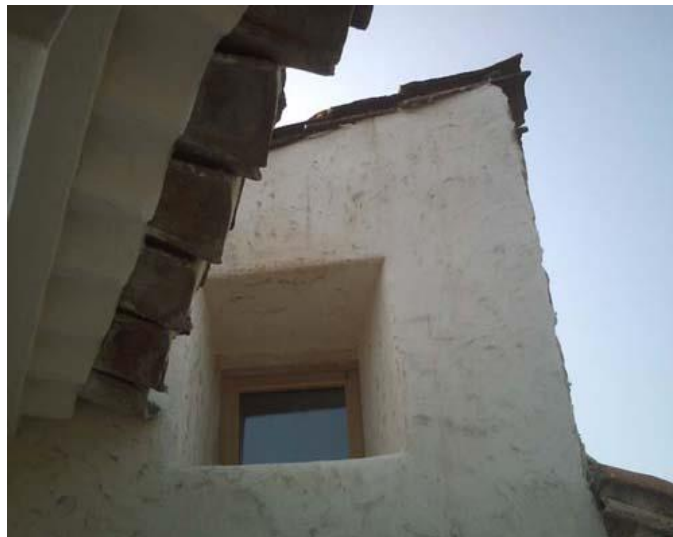
Figura 8. Acabado Mortero Mixto.
