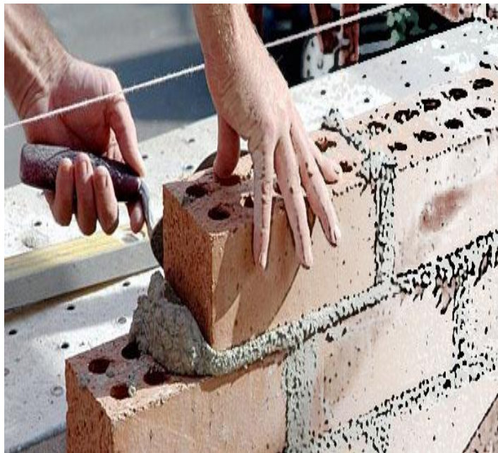
Figura 2. Pegado de elementos de mampostería.
