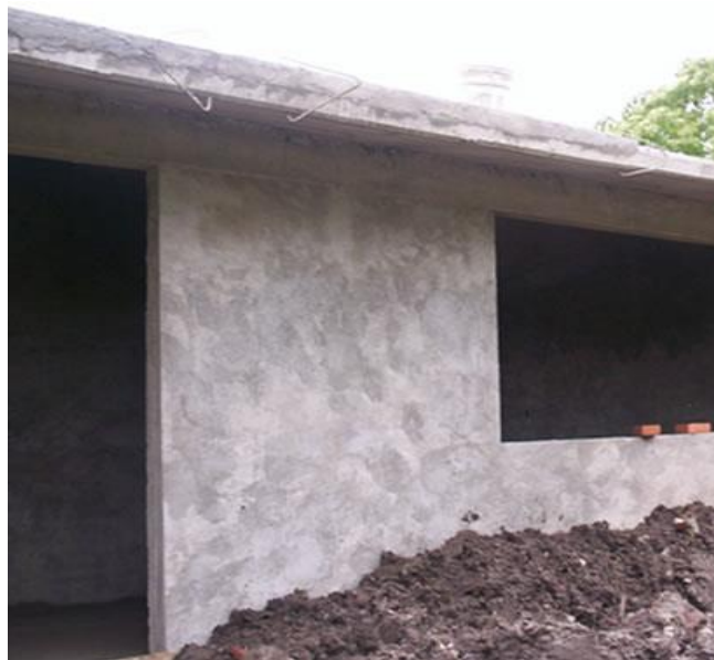
Figura 6. Aplicación cemento arena.
