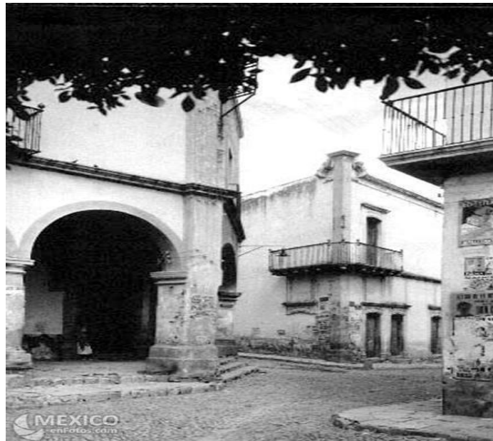
Figura 17. Deterioro a causa de la humedad proveniente de la cimentación. Ubicada en el centro de Querétaro.
