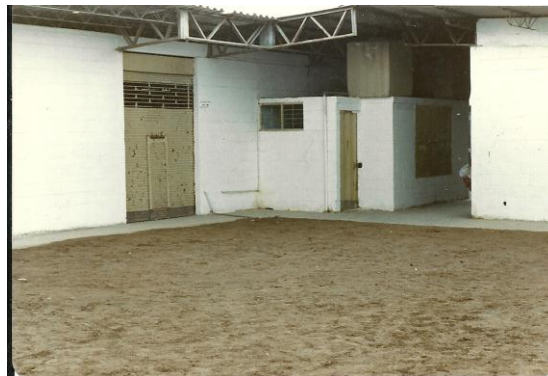
Fuente: Mario Rangel Cárdenas. Foto 9. Puerta del auditorio del mercado (remodelado), 1985.
