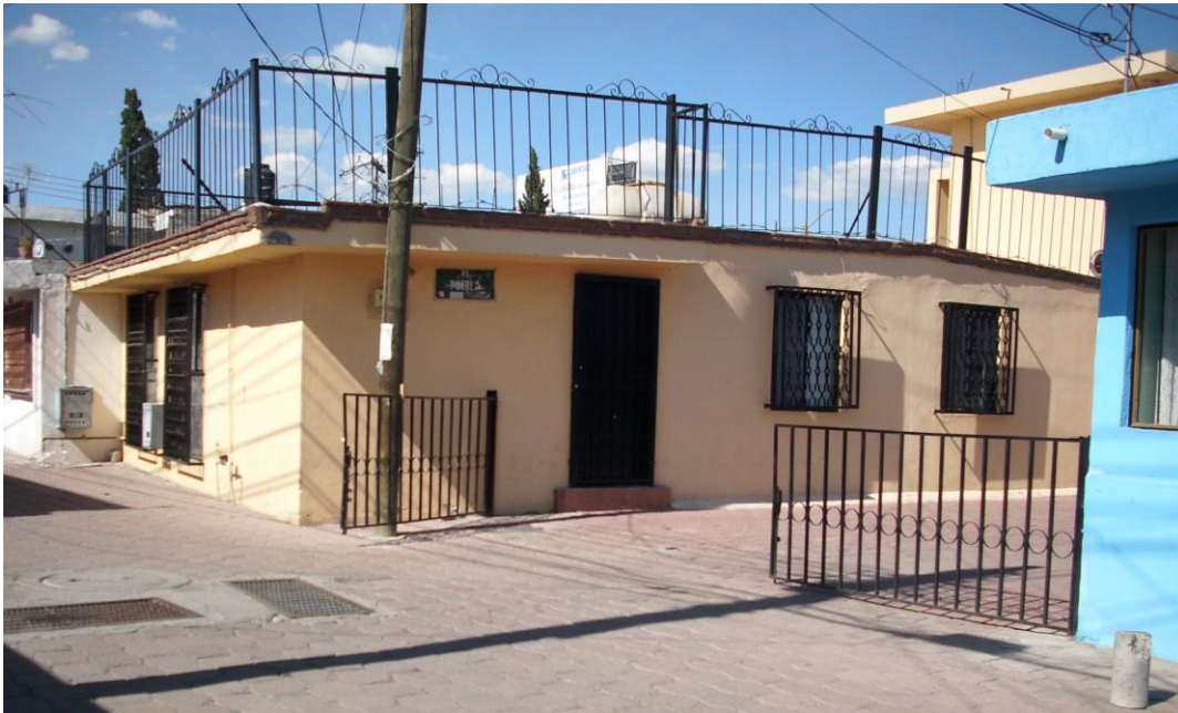
Fuente: Digna Neri. Foto 4. Calle Puebla primera sección, Colonia Obrera, 28 de septiembre de 2011.
