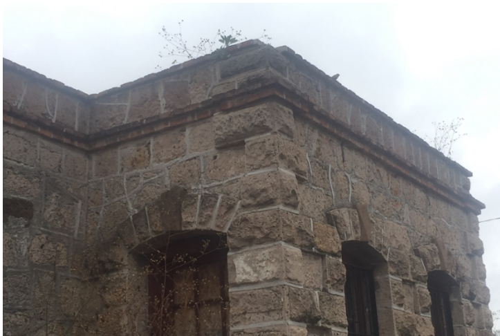
Ilustración 4. Condiciones actuales de la estación Rayón (Elaboración Propia)
