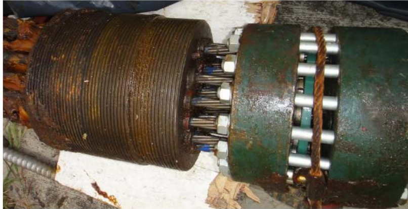
Figura 3.- Sistema de anclaje inferior de un tirante de un puente.
