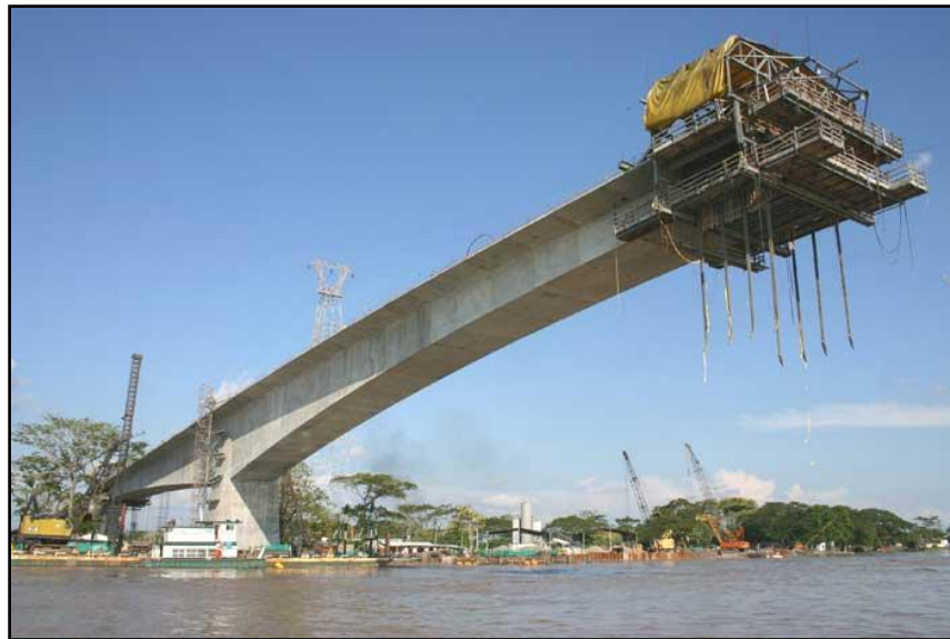
Figura 2.3 Fotografía de un puente en voladizo Fuente: http://www.flotaps.com/galeria_puentes.asp
