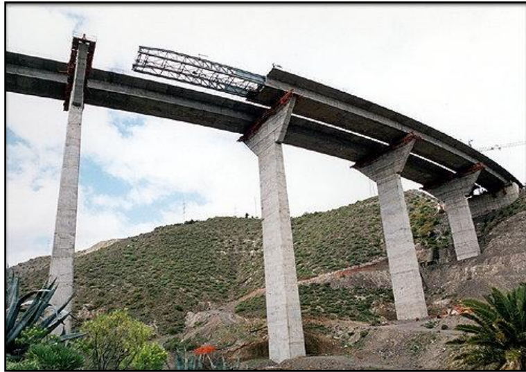
Figura 2.4 Fotografía de un puente empujado Fuente: http://www.flotaps.com/galeria_puentes.asp
