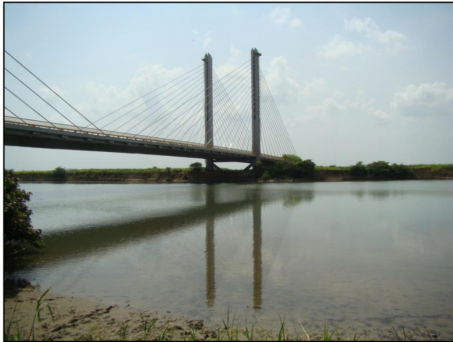
Figura 2.11 Puente Atirantado, Río Papaloapan Fuente: Instituto Mexicano del Transporte, 2008.
