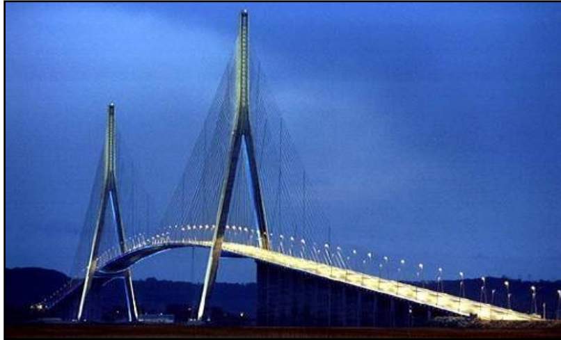
Figura 2.14 Fotografía del puente de Normandía en Francia
