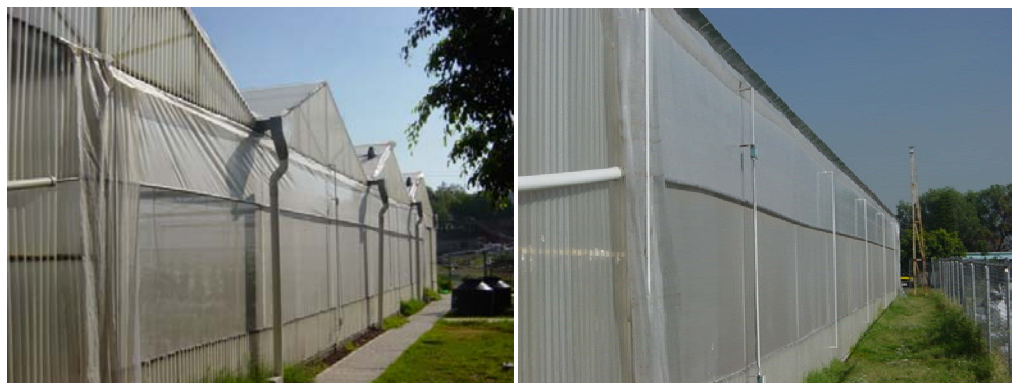
Figura 2.1 Invernadero Campus Universitario. 1,000m 2 . Tipo multicapilla a dos aguas. Ubicación: Cerro de las Campanas, Qro.
