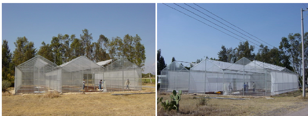
Figura 2.3 Invernadero Veterinaria. 430 m 2 . Tipo multicapilla con paredes de policarbonato. Ubicación: Amazcala, Qro.
