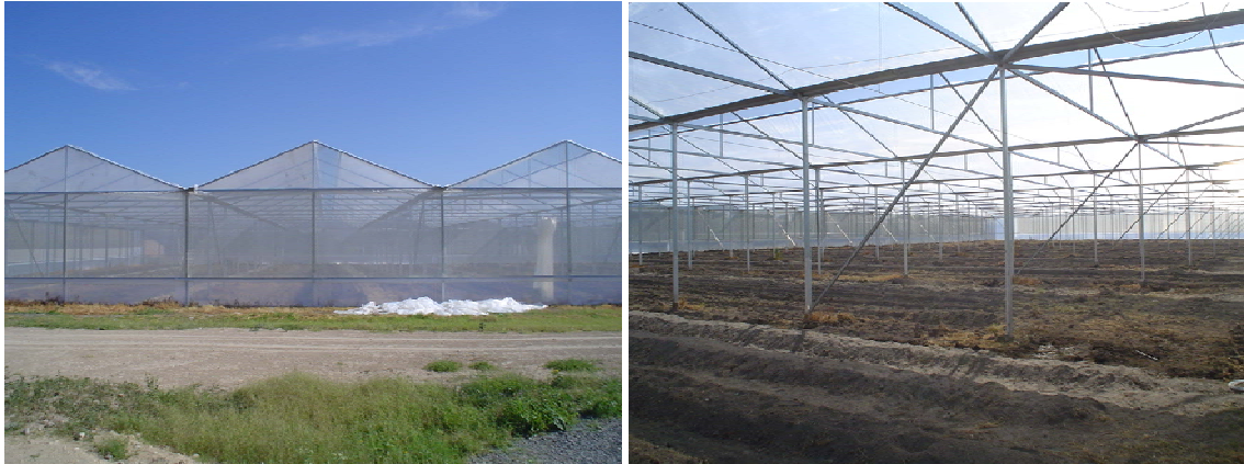
Figura 2.7 Invernadero Amazcala. 5,000m 2 . Tipo multicapilla a dos aguas. Ubicación: Amazcala, Qro.
