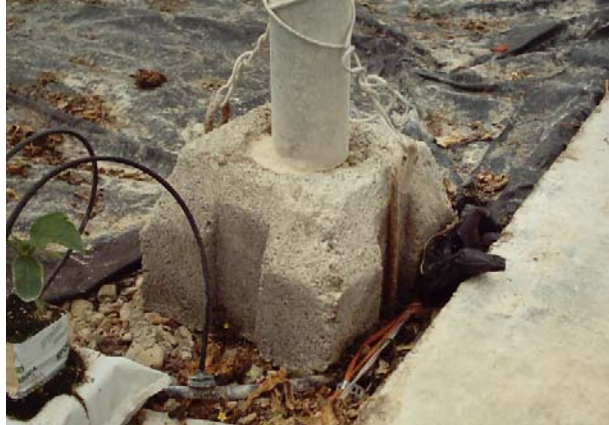
Figura 3.2 Invernadero tipo parral. Soportes tronco-piramidales perimetrales.(Rico, 2004)
