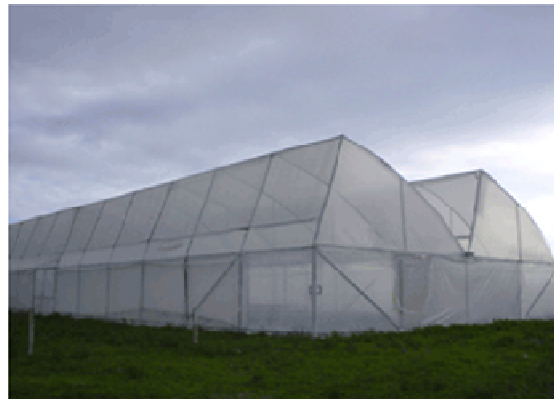
Figura 2.8 Invernadero Amazcala M1. 470m 2 . Tipo multicapilla asimétrico. Ubicación: Amazcala, Qro.
