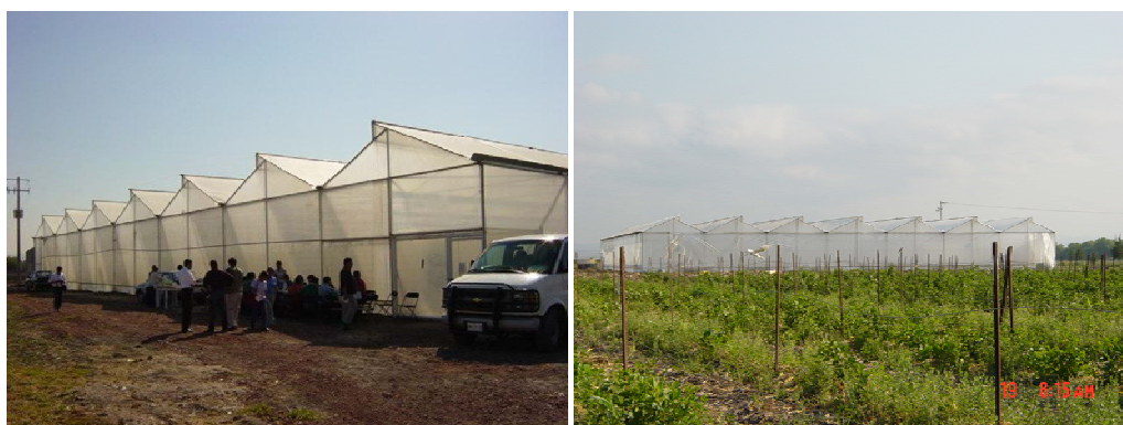
Figura 2.2 Invernadero Corregidora. 2,000m 2 . Tipo multicapilla diente de sierra. Ubicación: Corregidora, Qro.
