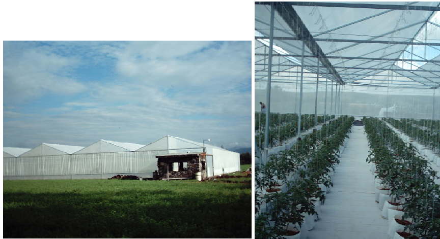
Figura 2.4 Invernadero Tecozahutla. 2,000m 2 . Tipo multicapilla a dos aguas. Ubicación: Tecozahutla, Hgo.
