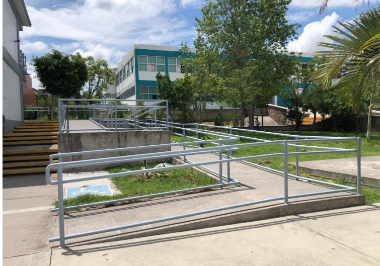
Figura 4.28 Rampa para sillas de ruedas utilizada para pruebas de funcionamiento
