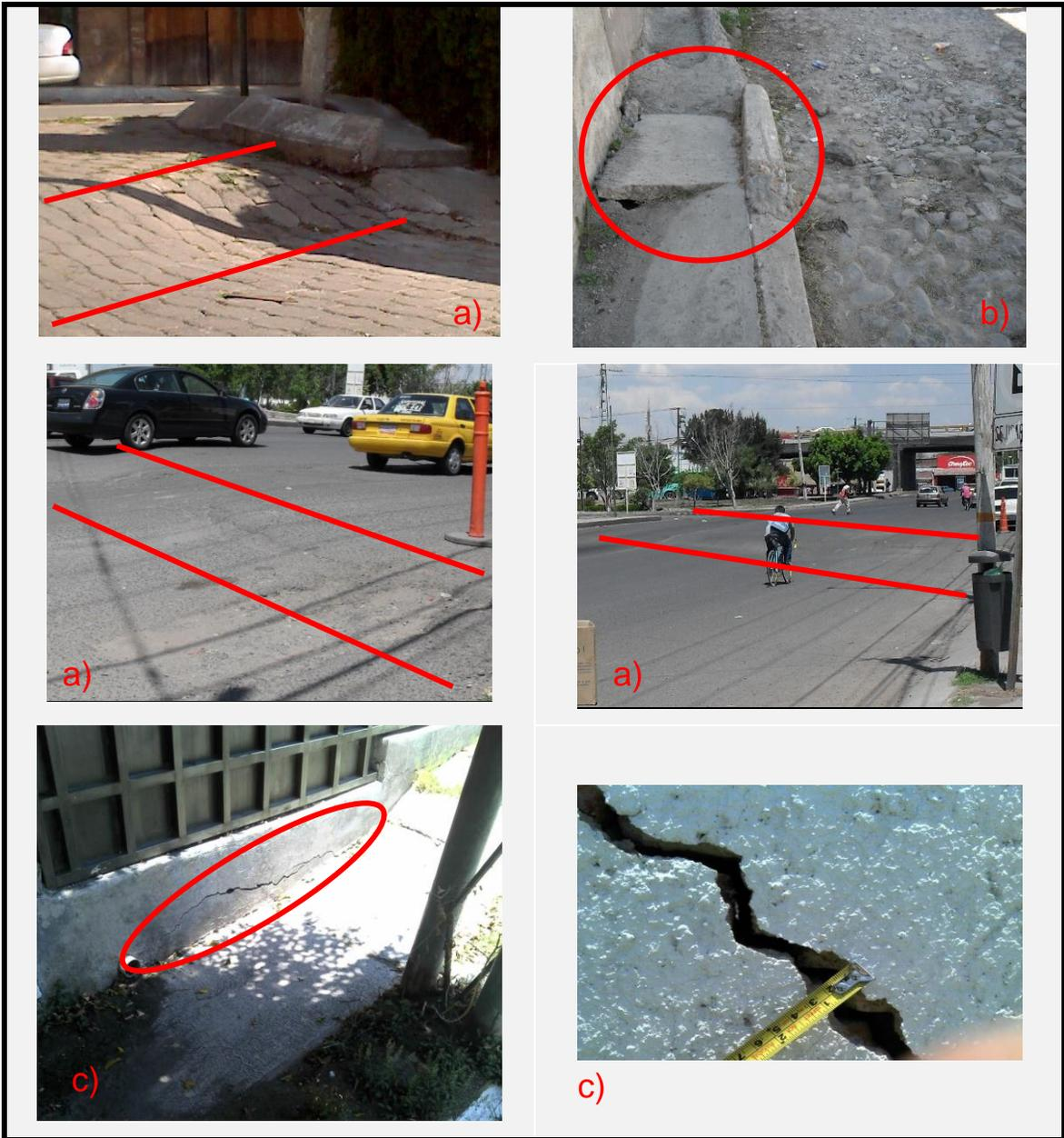
Figura 2.1. a) Asentamientos diferenciales, donde se tiene fracturamiento de la capa de rodadura, b) destrucción de banquetas, c) grietas en casas de colonia el Ensueño.
