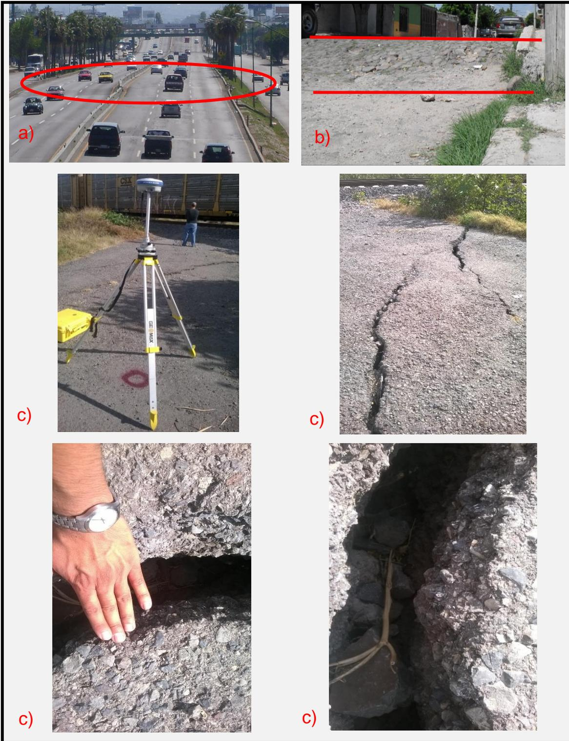
Figura 2.2. a) Vados en Av. 5 de Febrero, b) Falla por subsidencia en colonia la Sierrita, c) Aparición de grietas por extracción de agua
