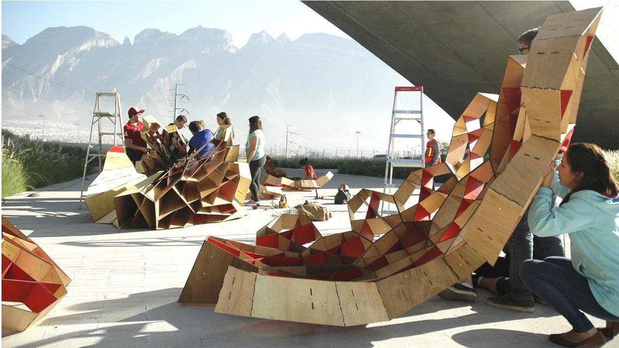
**Figura 27: Pabellón *Bicho3* fabricado en corte a laser y otras técnicas por alumnos de la UDEM. Fuente: ArchDaily (2015)**
