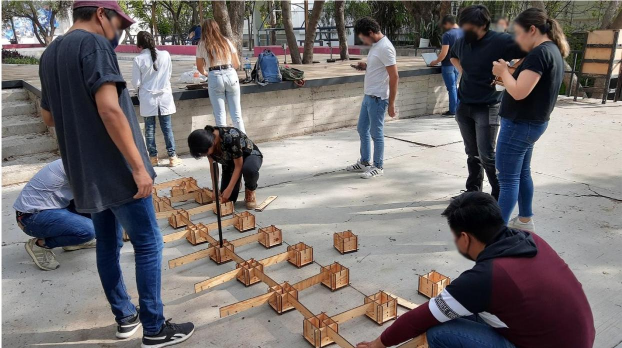
**Figura 70: Equipo Anticubierta, desarrollando procesos de ensamblaje con las piezas previamente cortadas a laser, esto dentro del espacio de la plaza del edificio I. Fuente: Diplomado en diseño y composición paramétrica (2021)**
