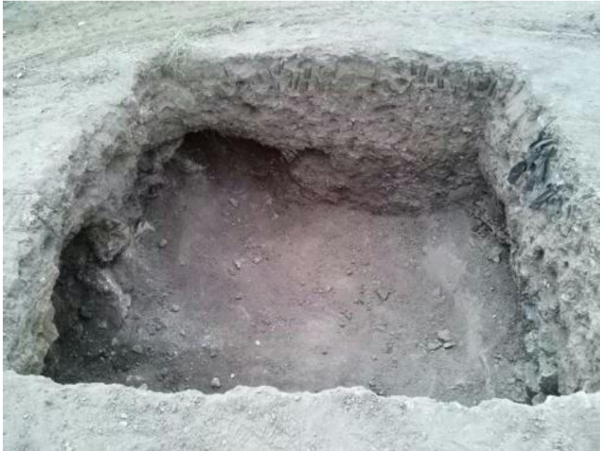
9-18 Exvacación de terreno terminada.
