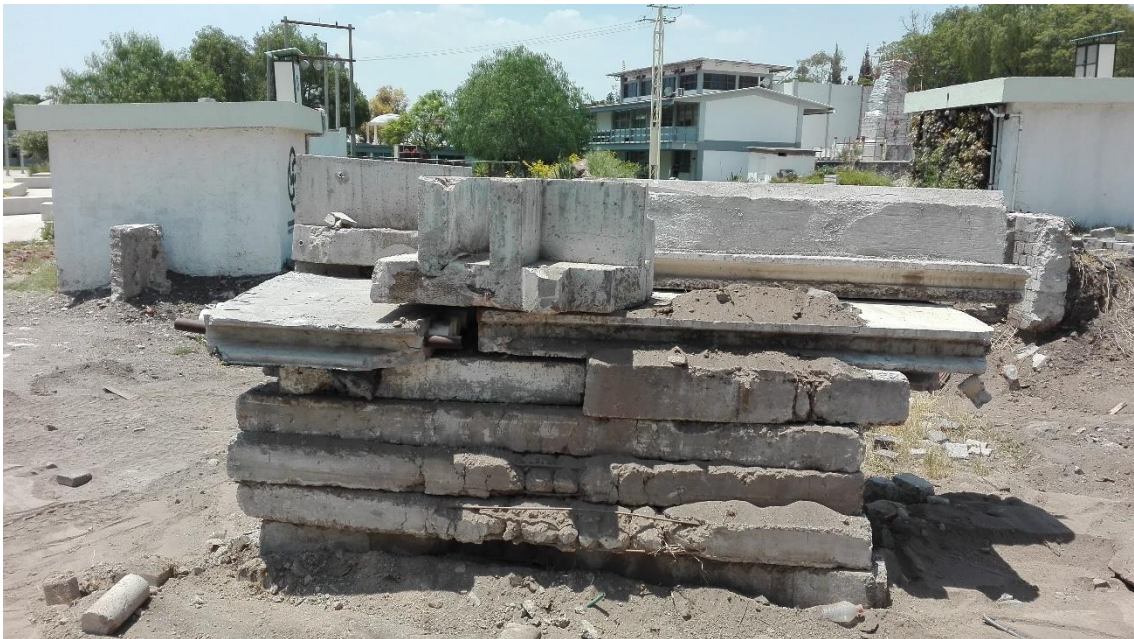
9-36 Carga estructural (3.24 ton/m 2 ) colocada en sitio.
