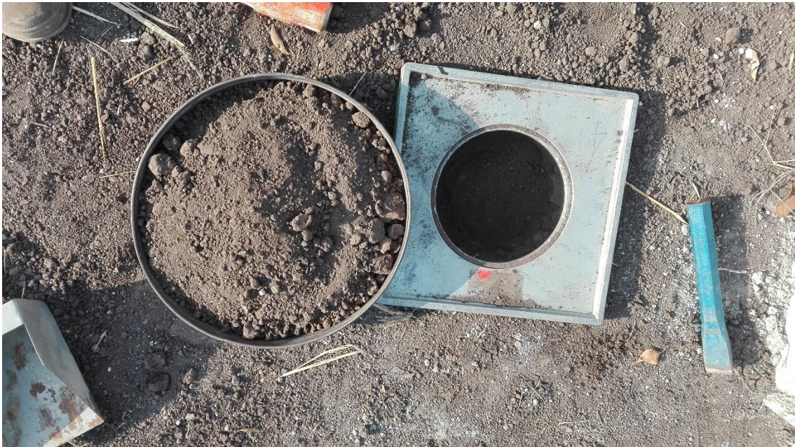
9-30 Prueba densidad in situ en proceso, excavación del hueco y el suelo extraído.
