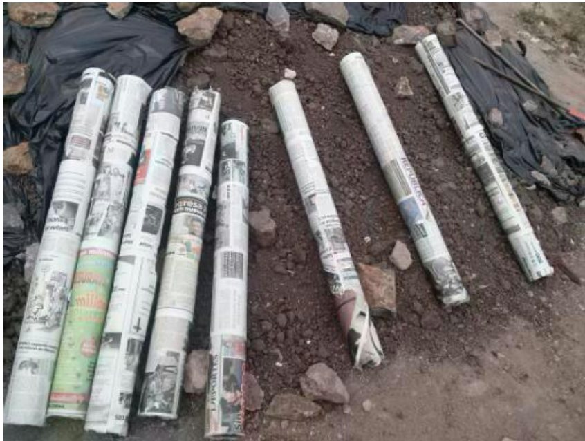
9-24 Tubos de Policloruro de vinilo (PVC) C80 envueltos en papel periódico listos para ser colocados en sitio.
