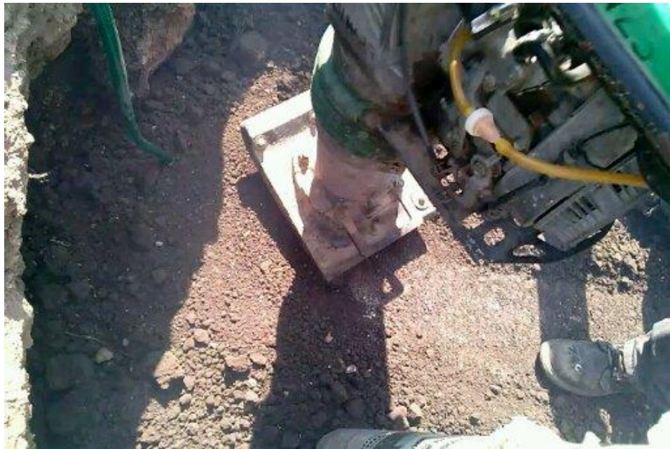
9-27 Procedimiento de compactación con humedad natural del suelo (11.06%).
