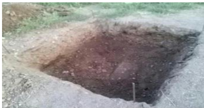
4-6 Excavación manual del terreno para reemplazar el suelo expansivo.
