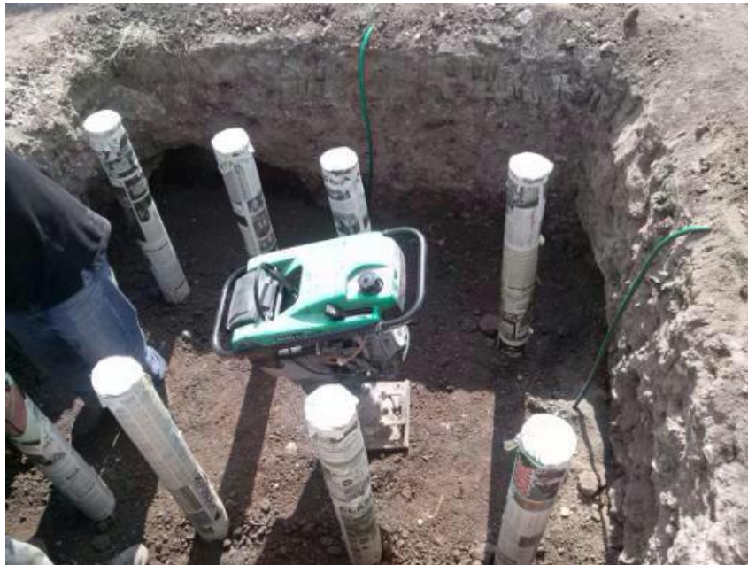
9-26 Procedimiento de compactación con la maquinaria vibro compactador.
