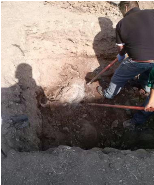
9-16 Extracción de cantos de roca con barras.
