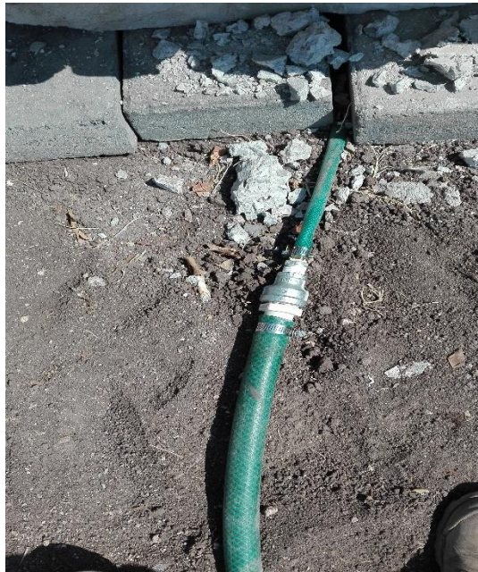
9-37 Conexión de mangueras para iniciar la saturación del suelo expansivo por capilaridad.
