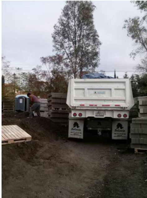
9-11 Terreno de sondeo y transporte de material en camión volteo de 7m 3 .
