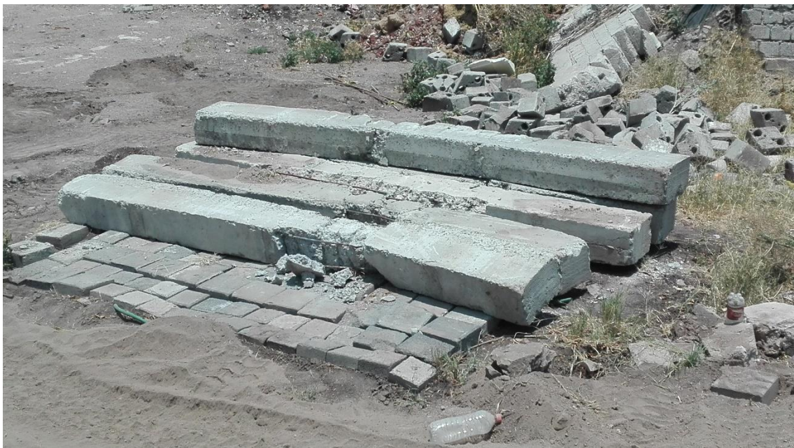
9-34 Colocación de vigas de concreto como carga estructural.
