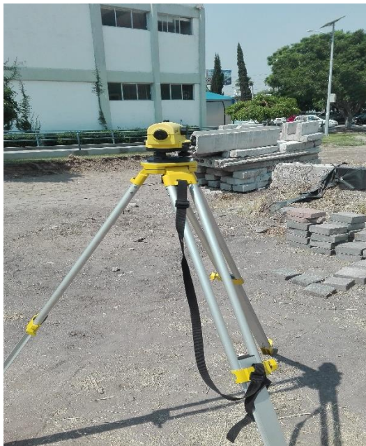
9-38 Nivel automático colocado en sitio para dar inicio a la nivelación topográfica.
