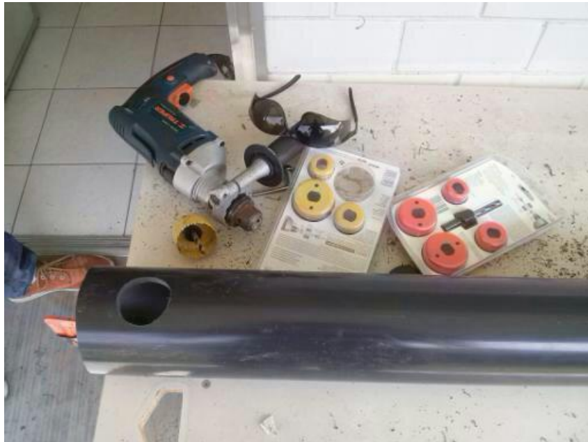
9-20 Herramienta menor para perforar el material de refuerzo Policloruro de vinilo (PVC) C80.
