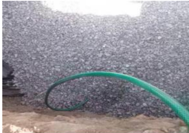
4-9 Vista en planta de la capa de grava y manguera.
