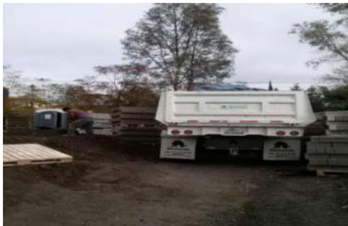
4-4 Camión de volteo de 7\text{m}^3 para el transporte del suelo expansivo.
