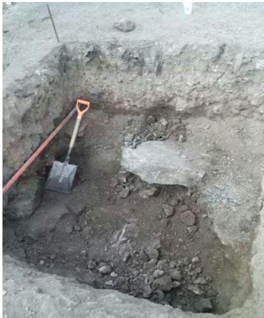
9-15 Herramientas menor pala y barra para realizar el procedimiento de excavación.
