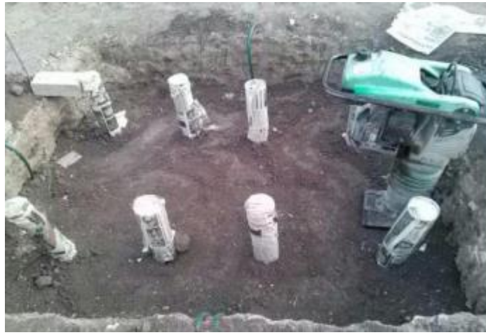
4-10 Compactación con apisonador Wacker Neuson.
