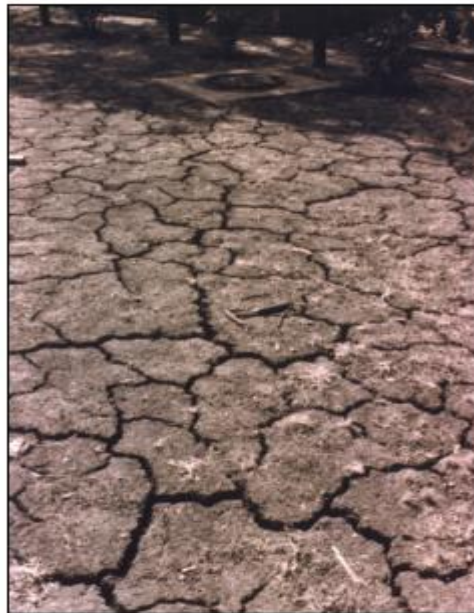
2-1 Grietas con patrones poligonales en la superficie del suelo en temporada de sequía. Estas grietas tienen aproximadamente de 2 a 5 cm (Rogers et al., 1993).
