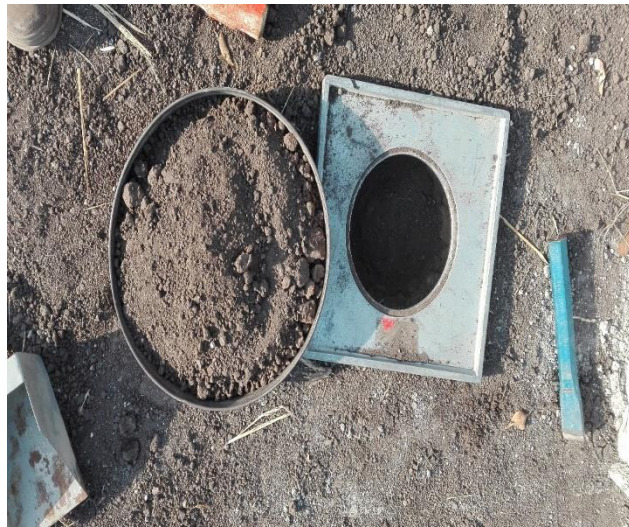
5-2 Excavación del agujero para rellenar con la arena del frasco.
