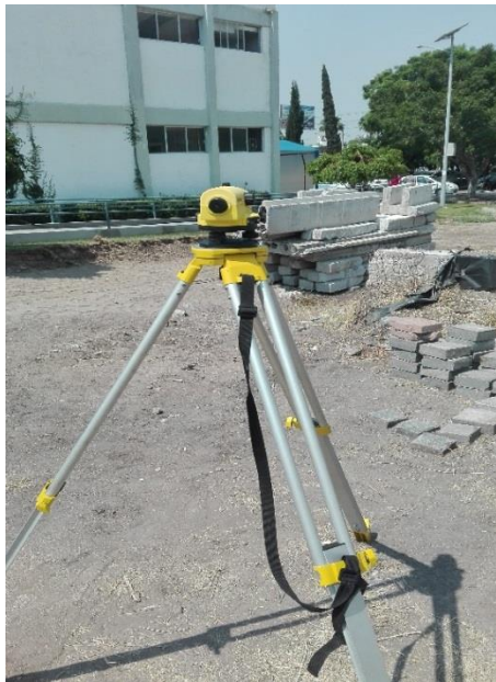
5-11 Nivelación topográfica con nivel automático.
