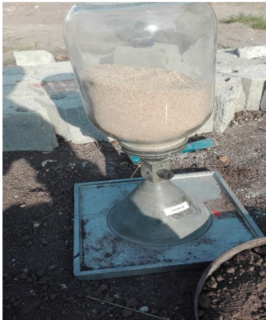
9-31 Arena fluendo del cono de arena hacia el hueco.
