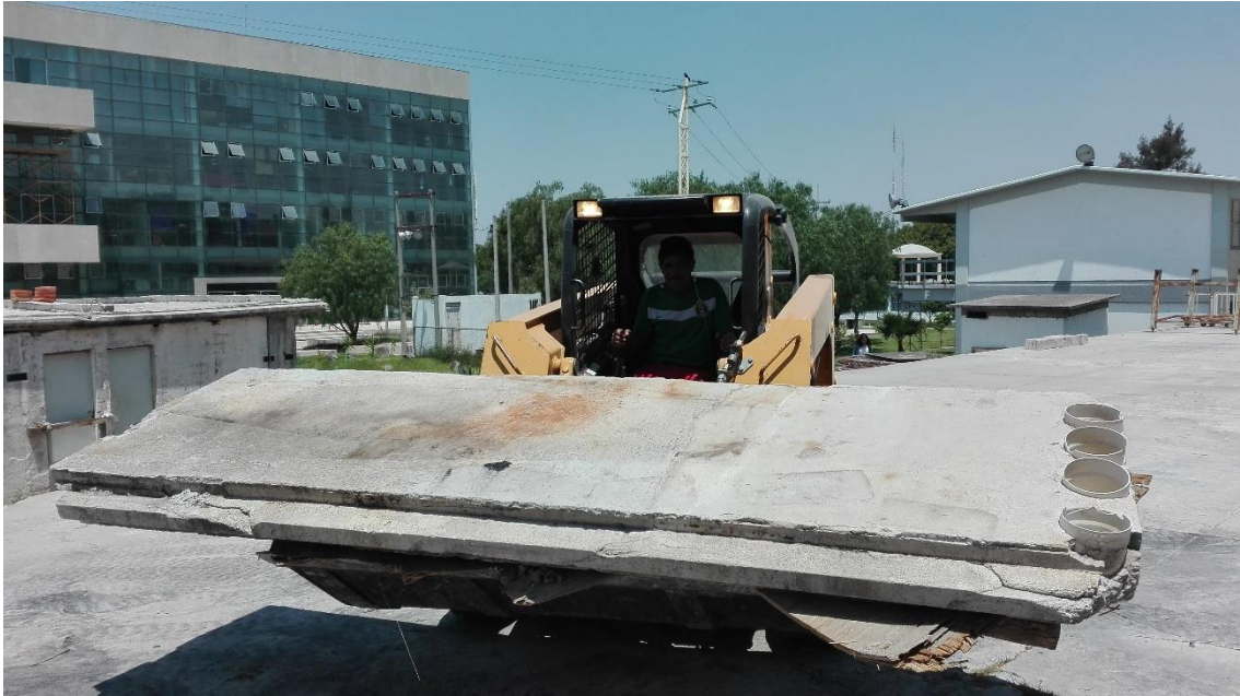
9-35 Losa aligerada maniobrada por un mini cargador BobCat para colocarla como carga estructural.
