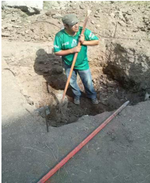
9-14 Excavación manual del terreno.
