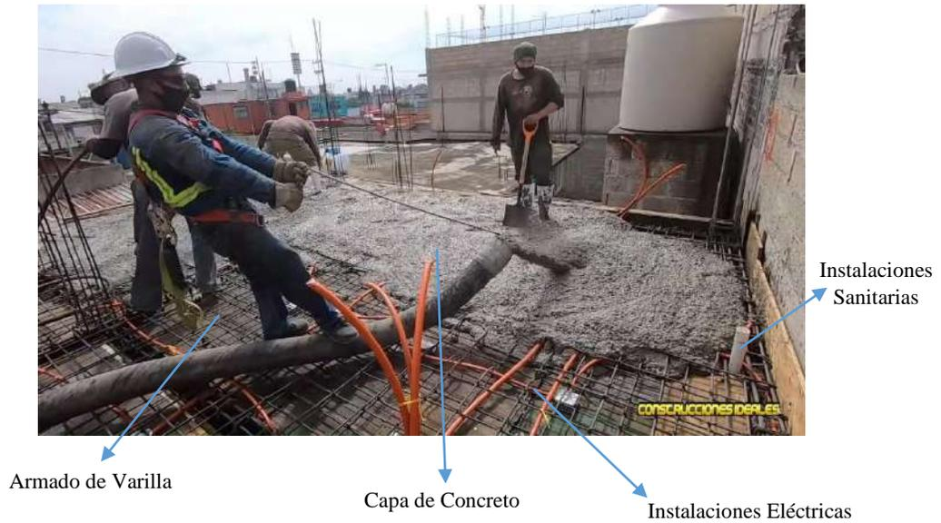
**Figura 2.2** Detalle de una losa maciza, (McCormac & Brown, 2016).
