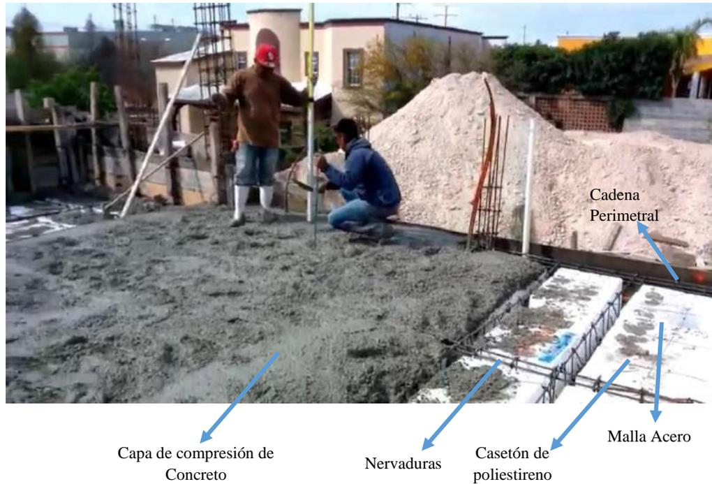
**Figura 2.6** Detalle de una losa reticular, (McCormac & Brown, 2016)
