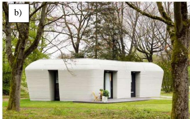
**Figura 2.1** a) Sistema Termodomo, (*Marín Ávila & Reynoso Miranda, 1998*), b) Casa construida mediante impresión 3D, (*Souza Aredon, Salet, & Kanuff, 2019*).
