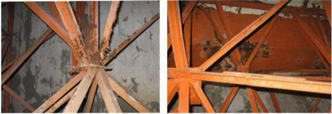
**Figura 2.19** Daño por corrosión del acero en una tridilosa del Centro social y de usos múltiples en Macuspana Tabasco, (Frei & Solís Ávila, 1985).
