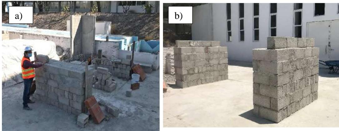
**Figura 4.3** a) Construcción de las bases, b) Bases terminadas (Fuente propia, 2021).
