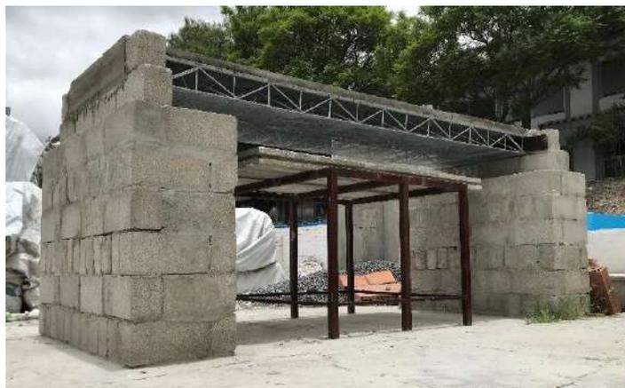
**Figura 4.12** Preparación para el aplanado de la cara inferior del sistema LTM, (Fuente propia, 2021).
