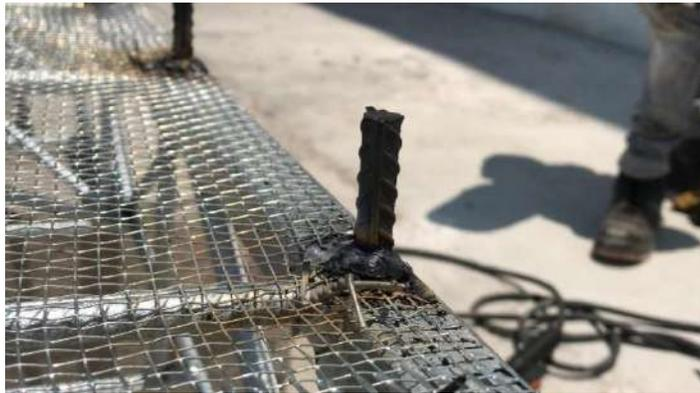
**Figura 4.6** Detalle pernos de sujeción, (Fuente propia, 2021).
