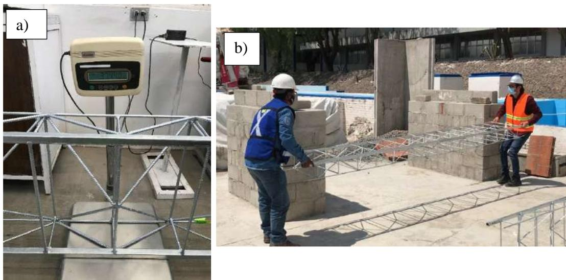
**Figura 4.5** a) Peso de un módulo del Sistema LTM, a) Presentación de Módulos del Sistema LTM con el acabado (Fuente propia, 2021).
