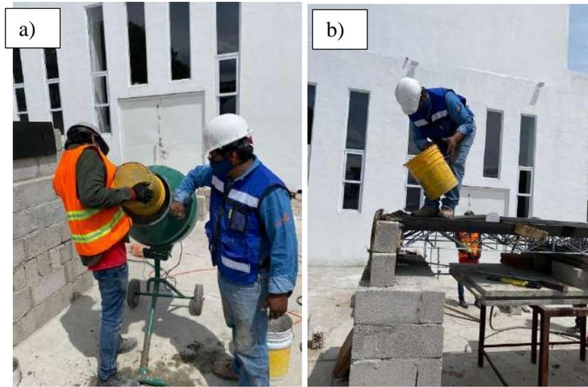
**Figura 4.11** a) Elaboración de la mezcla en sitio, b) vaciado de la mezcla, (Fuente propia, 2021).
