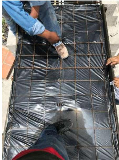
**Figura 4.10** Detalle de la colocación de la malla 6-6/10-10, (Fuente propia, 2021).
