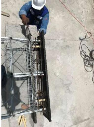
**Figura 4.8** Detalle del cimbrado, (Fuente propia, 2021).
