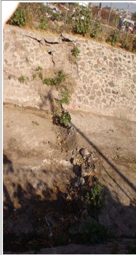
Figura V.12 Fractura de mamposteo en Dren enfrente de la empresa Pilgrims Pride.
