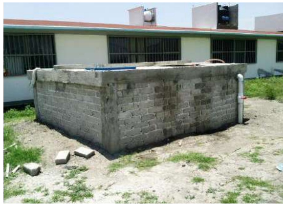
b) Aljibe de agua detrás de las aulas
