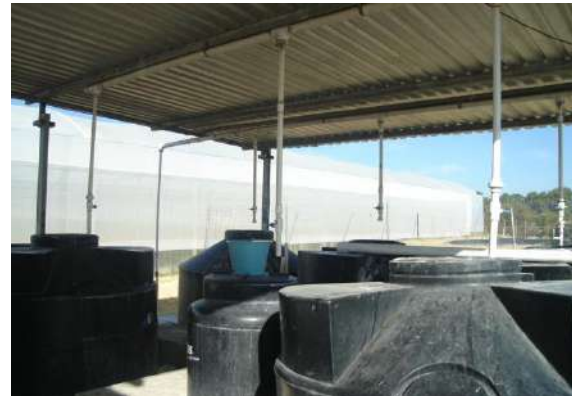
d) Tubería de pvc de tinacos del estanque de agua
