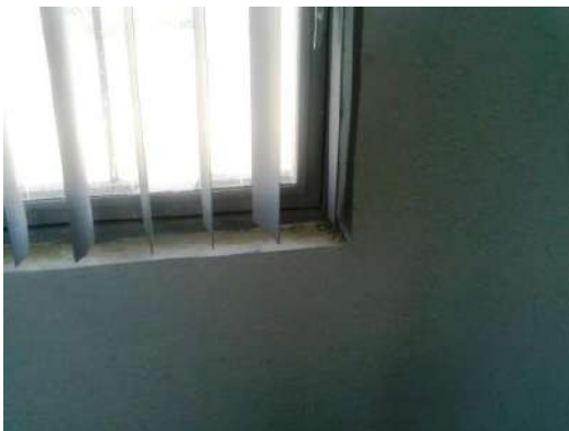
a) Esquina derecha de la ventana interior del aula
