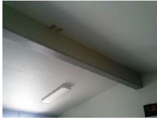
b) Techo de la parte izquierda del salón de elaboración de lácteos
