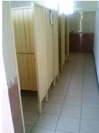
b) Pasillo de los sanitarios de damas
