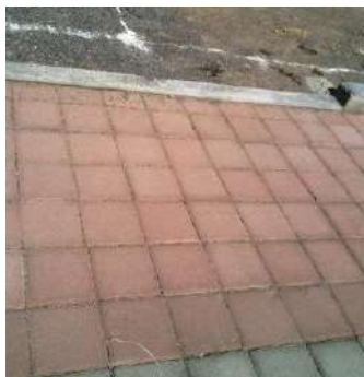
III-9 Pasillo exterior de las aulas con adoquín rosa
