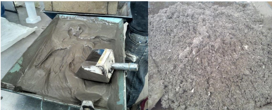
Figura 23 Mezcla de mortero para paneles ya homogéneo
