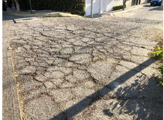
Figura 81. Pavimento de concreto hidráulico en la Calle Federico Samaniego.
