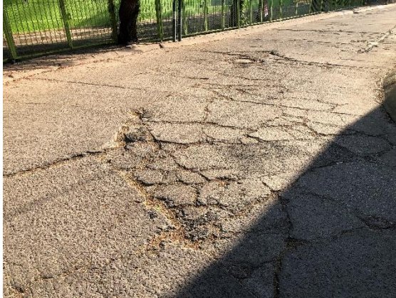
Figura 80. Pavimento de concreto hidráulico en la Calle Antonio Pérez Alcocer.
