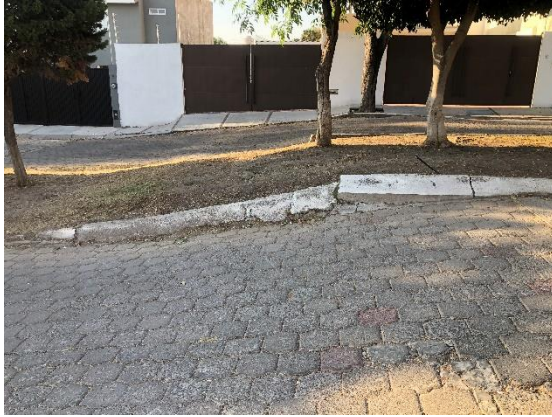
Figura 86. Pavimento articulado en la calle Cayetano Rubio (Sentido 1).
