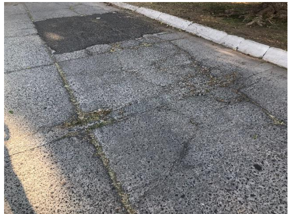
Figura 83. Pavimento de concreto hidráulico en la Calle Cayetano Rubio (Sentido 2).
