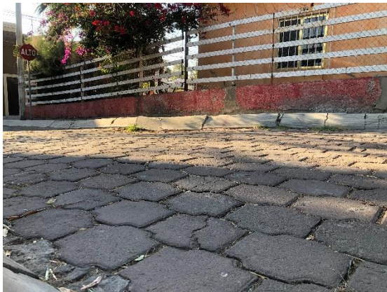
Figura 84. Pavimento articulado en la calle Paseo del Gorrión.
