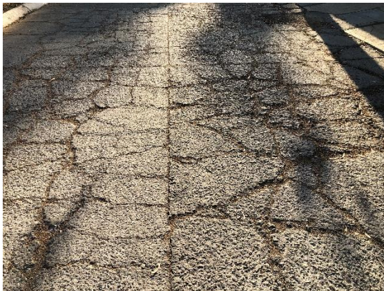
Figura 82. Pavimento de concreto hidráulico en la Calle Cayetano Rubio (Sentido 1).
