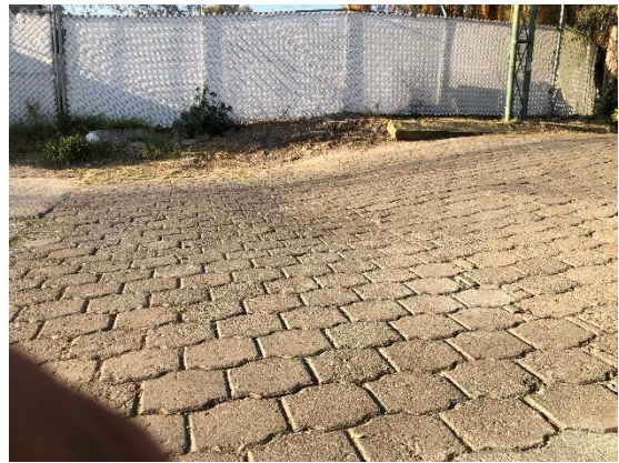
Figura 85. Pavimento articulado en la calle Federico Samaniego.
