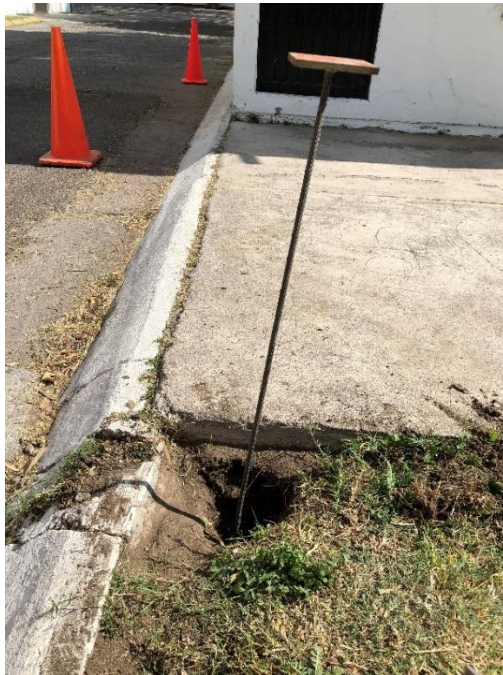
Figura 18. Colocación de punto de control. Fuente: Elaboración propia (2019)
