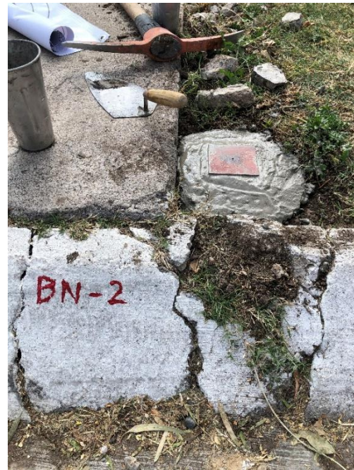
Figura 19. Resultado final de la colocación de punto de control. Fuente: Elaboración propia (2019)
