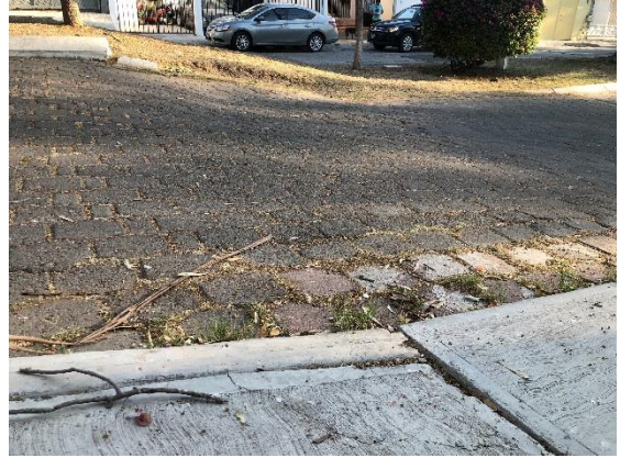
Figura 87. Pavimento articulado en la calle Cayetano Rubio (Sentido 2).
