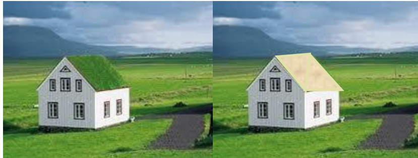
Fig. 1.2. Ejemplo de casa con techo verde y casa con pintura de bajo coeficiente térmico.
