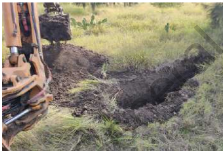
e) Labrado de muestra inalterada.
