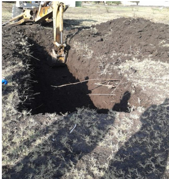
FIGURA 5.1.Extraccion de muestras alteradas e inalteradas.
