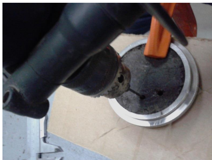
FIGURA 5.9. Método de realización de perforaciones.
