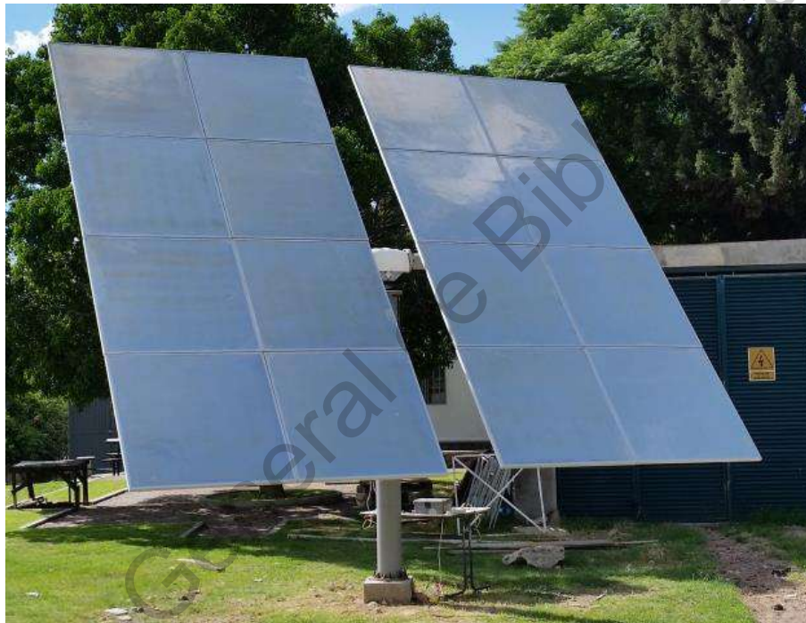
Figura 42. Estructura mecánica del heliostato.
