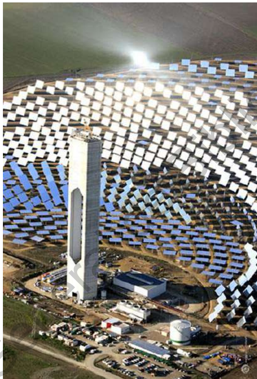
Figura 3. Distribución del campo de heliostatos de la planta solar PS20 (Camacho et al., 2012).
