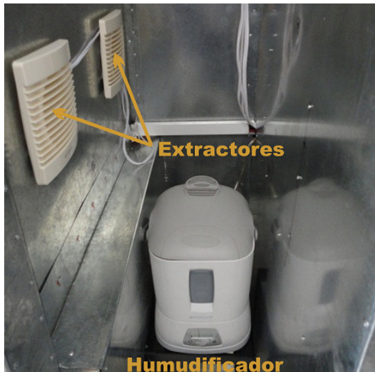
(a) Instalación del humidificador
