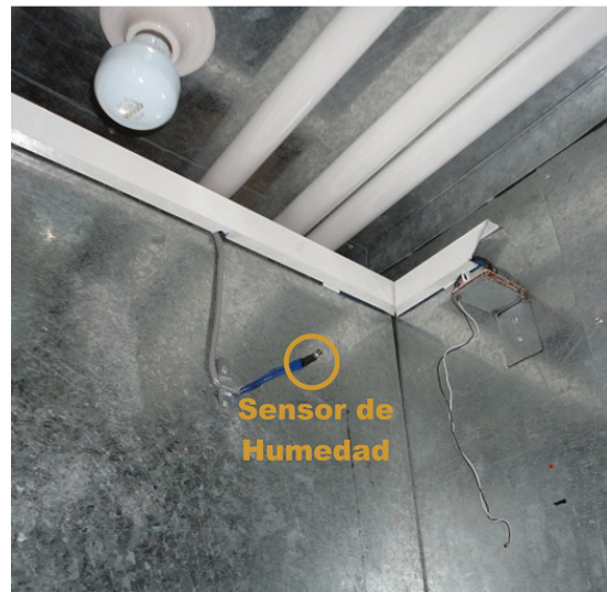
(b) Instalación de los sensores de humedad
