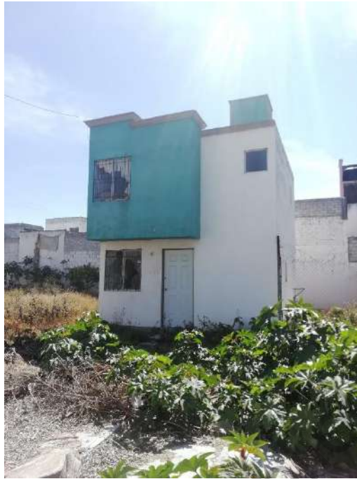
Figura 21: Vivienda abandonada del fraccionamiento La Aurora. Elaboración propia
