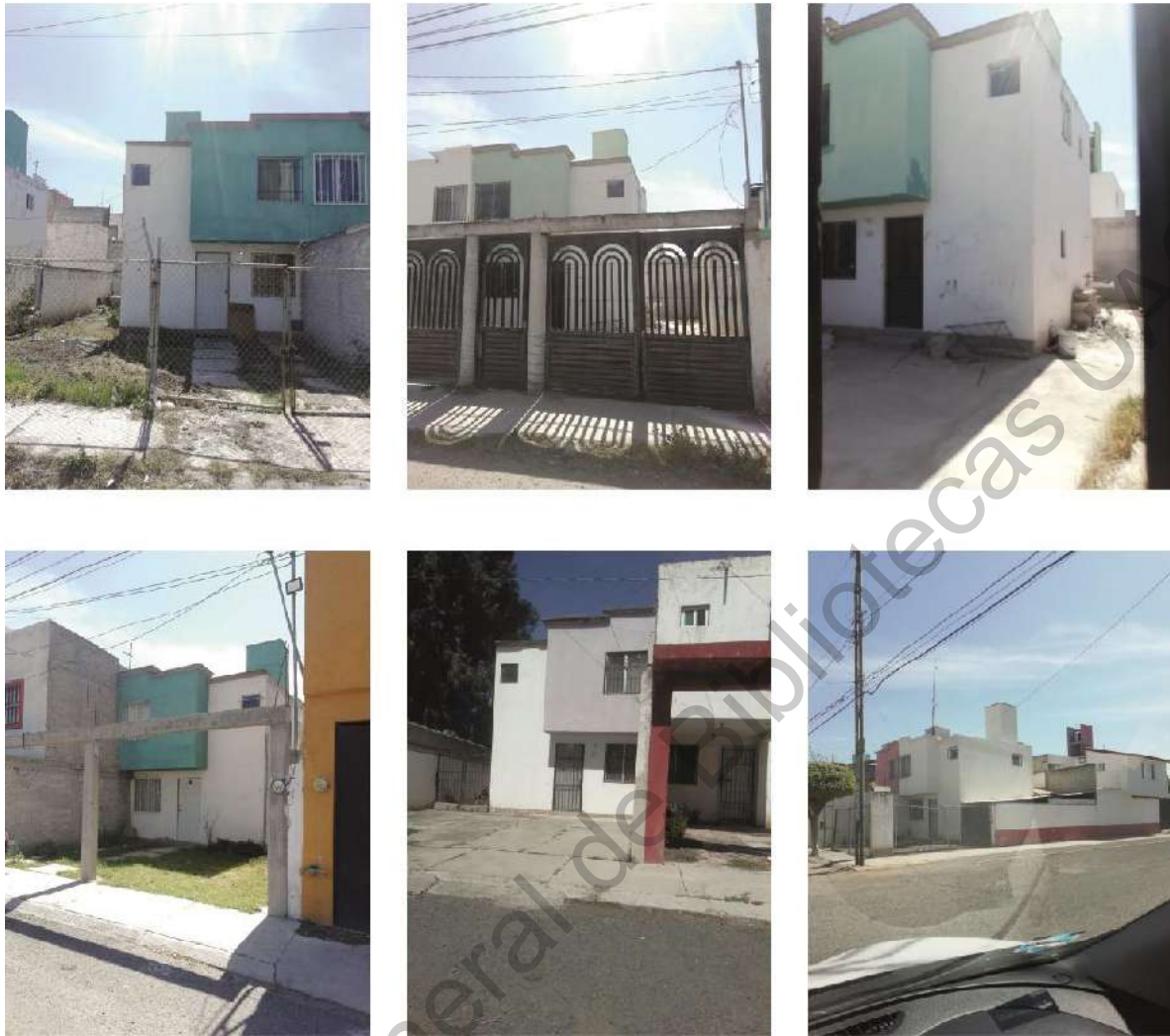
Figura 22: Viviendas deshabitada del Fraccionamiento La Aurora. Elaboración propia.
