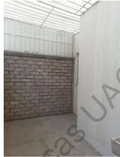
Figura 52: Patio de servicio del caso de estudio. Elaboración propia.
