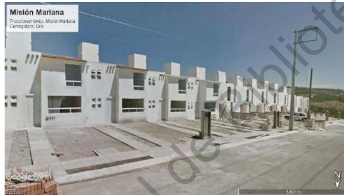
Figura 44: Vista frontal de viviendas del Fraccionamiento Misión Mariana, Corregidora, Querétaro. (Google, 2020)
