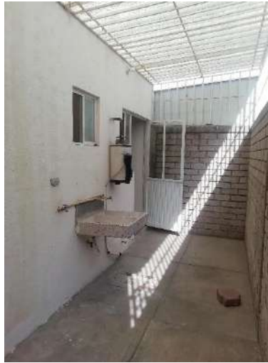
Figura 51: Patio de servicio del caso de estudio. Elaboración propia.
