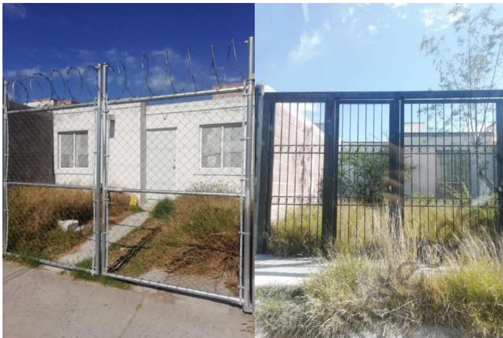
Figura 31: Viviendas deshabitada del Fraccionamiento San Miguel. Elaboración propia.
