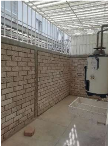
Figura 50: Patio de servicio del caso de estudio. Elaboración propia.
