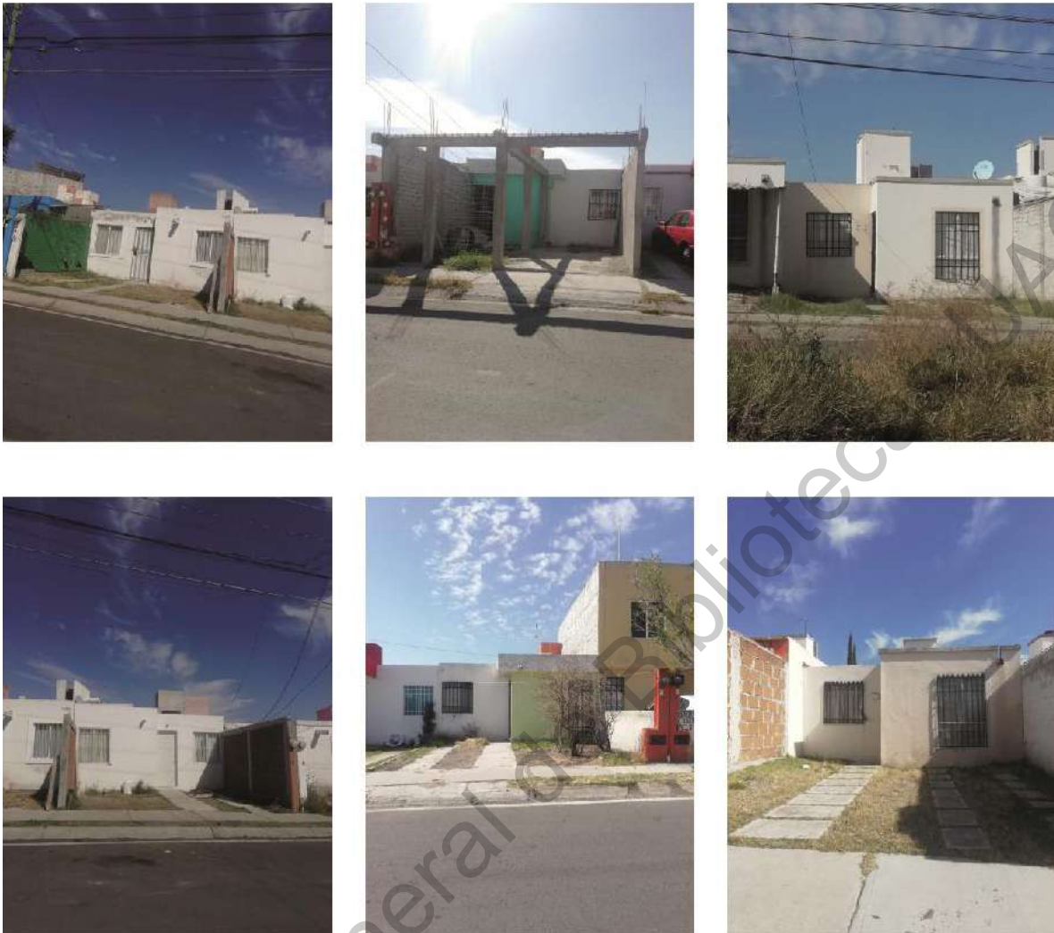
Figura 32: Viviendas deshabitada del Fraccionamiento San Miguel. Elaboración propia.
