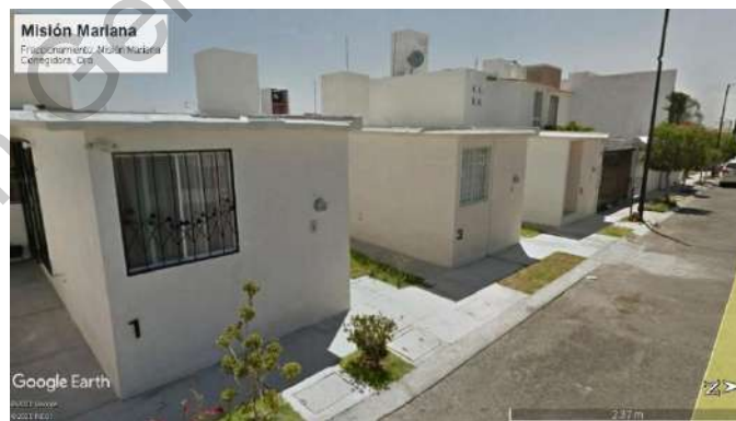
Figura 45: Vista frontal de viviendas del Fraccionamiento Misión Mariana, Corregidora, Querétaro. (Google, 2020)
