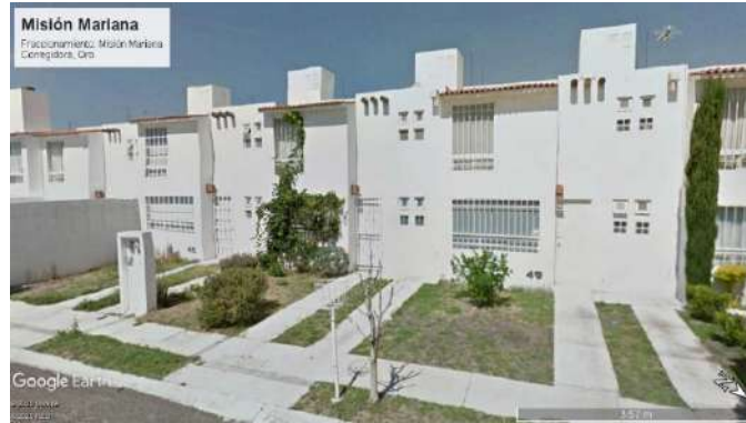
Figura 43: Vista frontal de viviendas del Fraccionamiento Misión Mariana, Corregidora, Querétaro. (Google, 2020)
