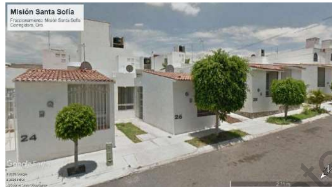
Figura 41: Vista frontal de viviendas del Fraccionamiento Misión Santa Sofía, Corregidora, Querétaro. (Google, 2020)
