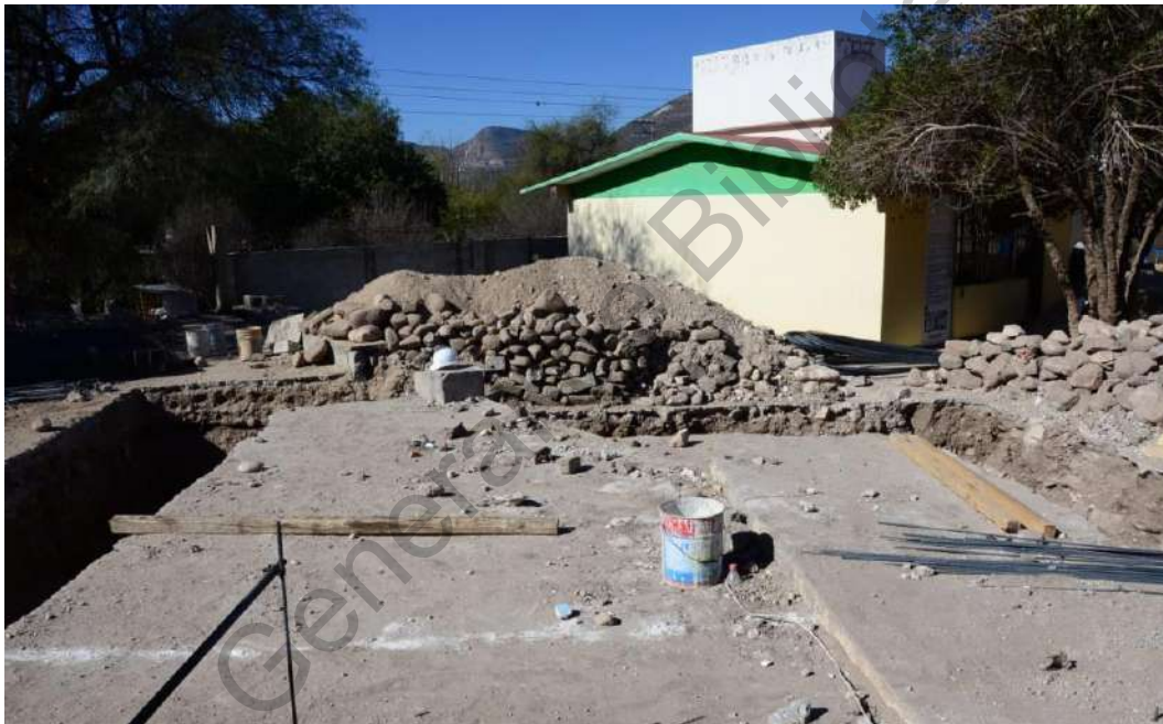
Construcción de cancha deportiva
