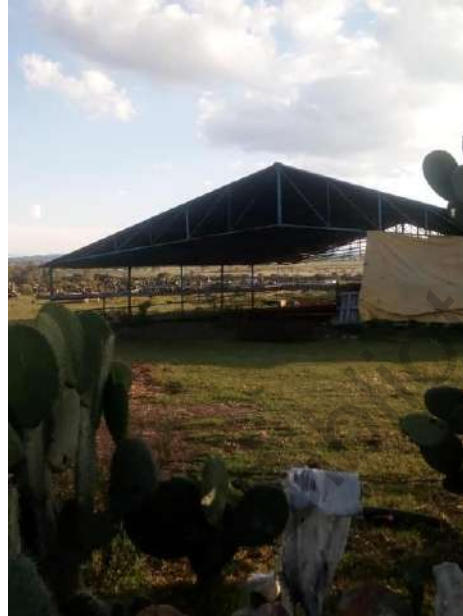
Imagen 7. Exterior del establo de don Jorge con estructura tubular
