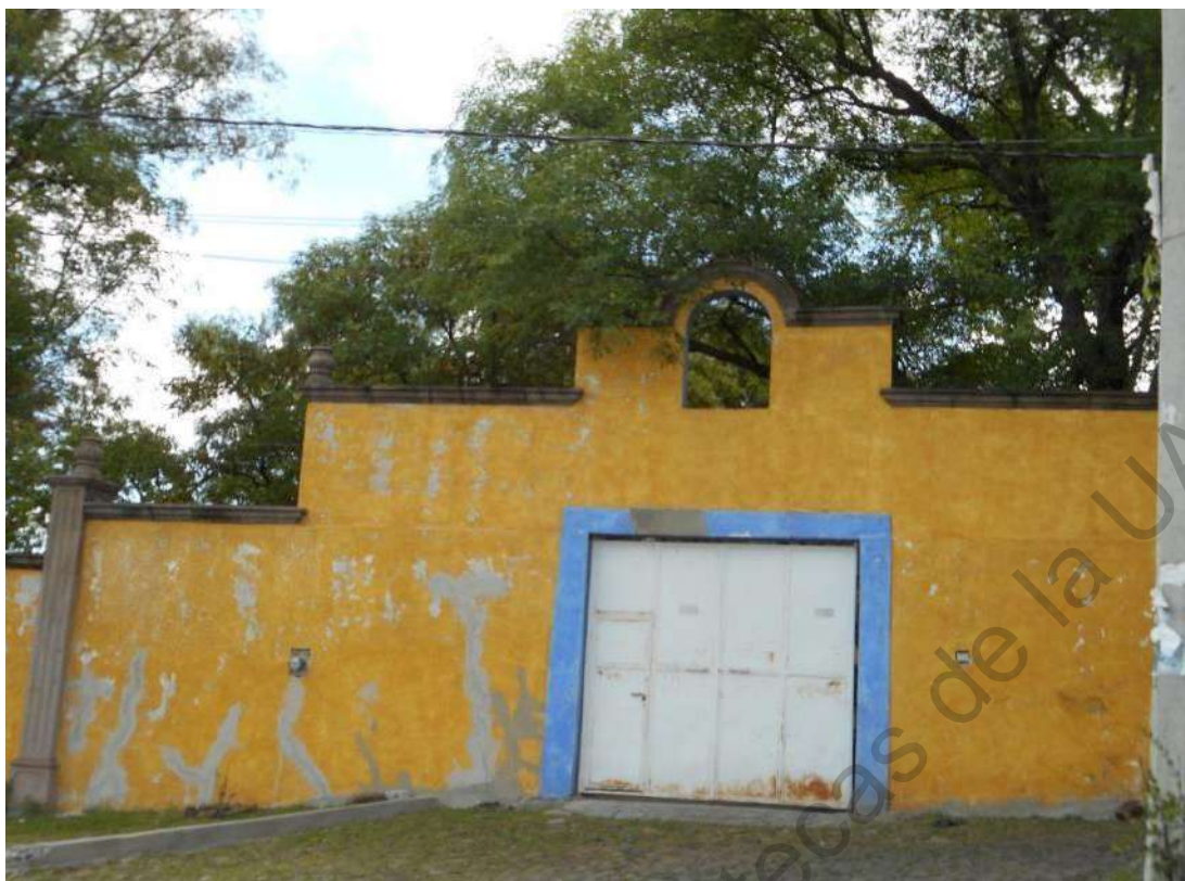
Foto 3. Parte externa de la ex hacienda. Escolásticas, 1/11/16. Acervo personal.
