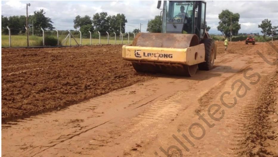
**Figura 2.2 Subbase en un pavimento**
