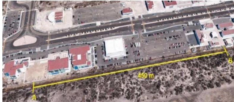
FIGURA 5.7 Área de instalación de la turbina eólica y el anemómetro.
