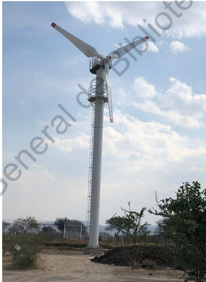
FIGURA 5.12 Aerogenerador tripala de 14 KW ubicado en la UAQ, campus aeropuerto. Fuente: Elaboración propia.
